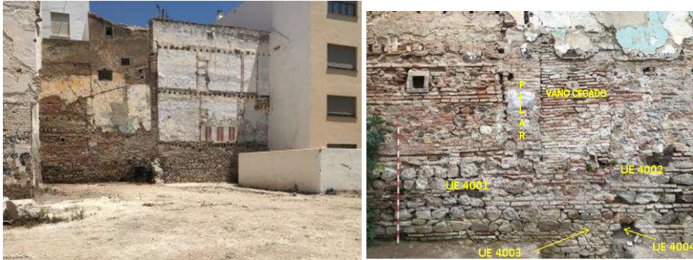
Lámina I y II. Parte del paramento intramuros.
