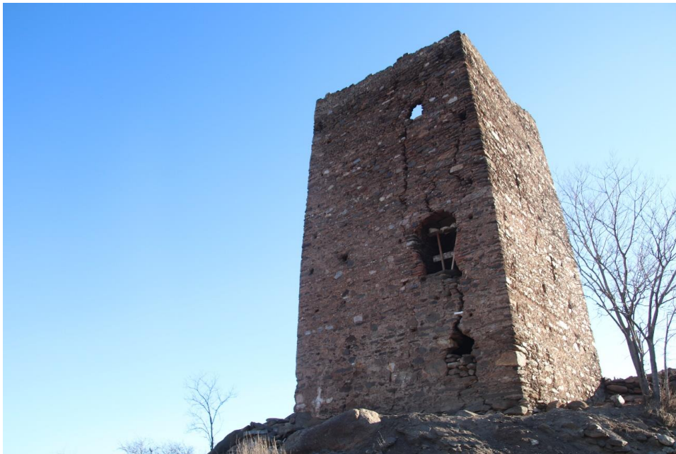
Figura 3 Vista de la torre desde el barranco en la parte O
