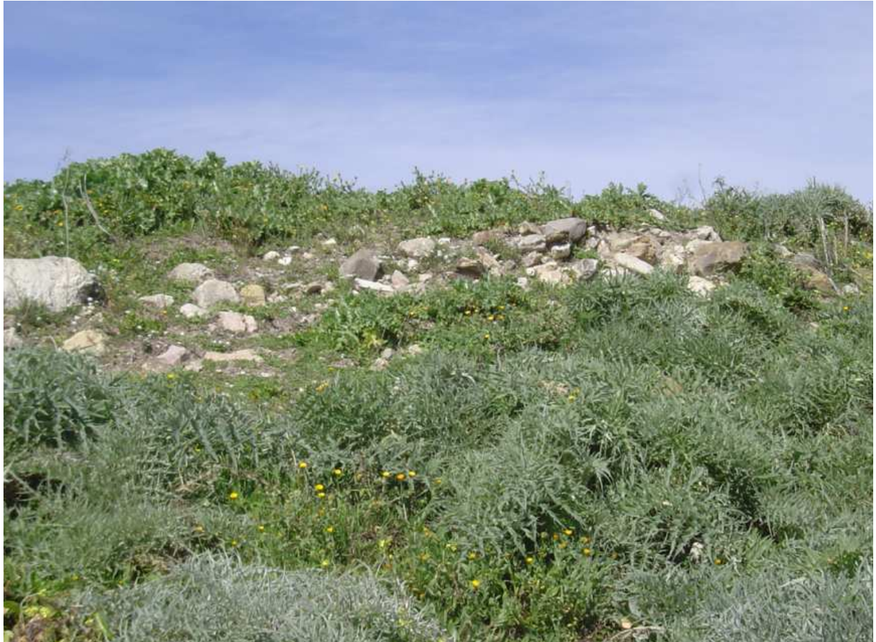
Base de cimentación que recorría toda la falda de la peña en su parte superior.
