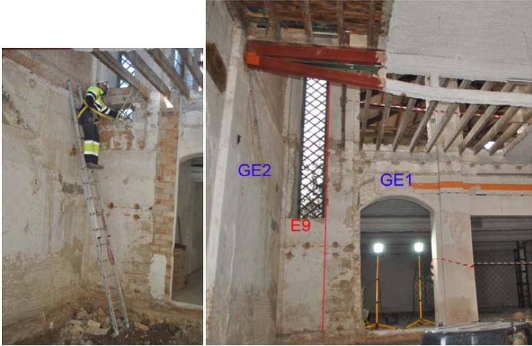
Retirada del cegamiento de la ventana. Ventana y unión de los dos edificios
