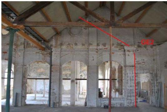
Muro de fachada desde el exterior, parte este con señalado del límite original y el añadido de GE2
