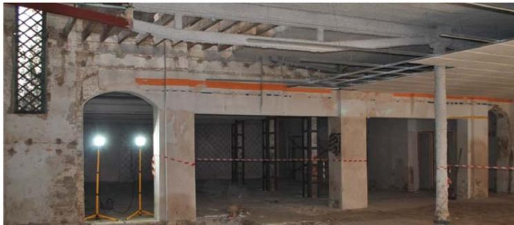
Fachada en planta baja, con dos de los pilares desaparecidos
