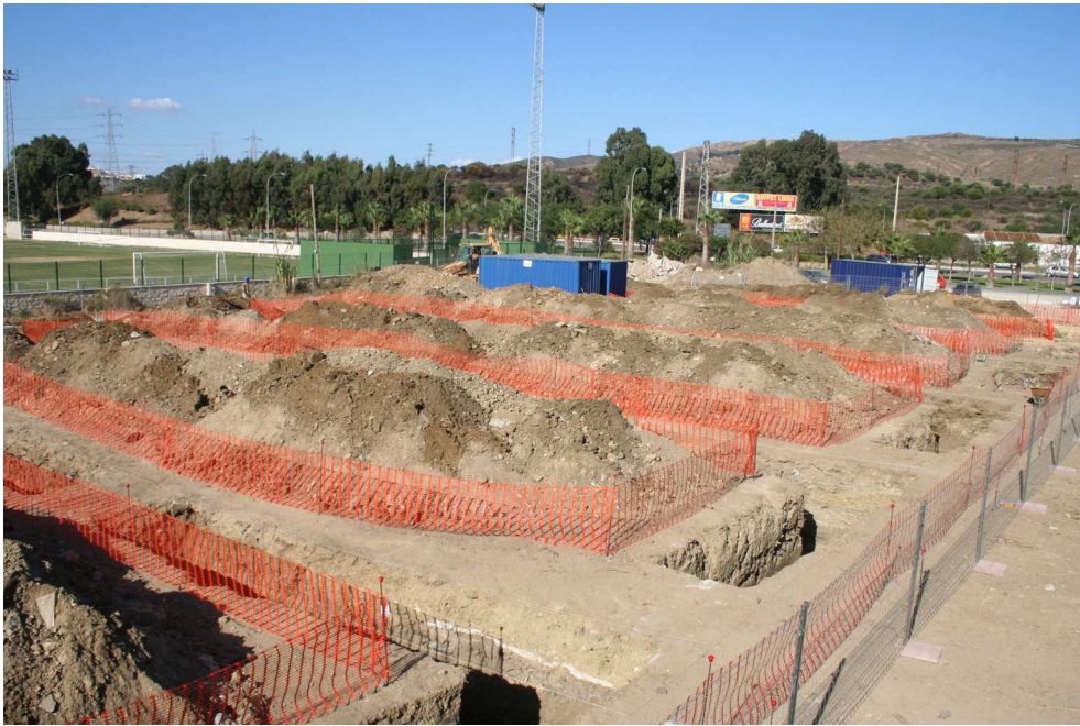
4.- Vista general de la parcela tras la finalización de los trabajos. Se aprecian todas las zanjas delimitadas con el vallado correspondiente, así como las distintas terreras generadas por el proceso de excavación
