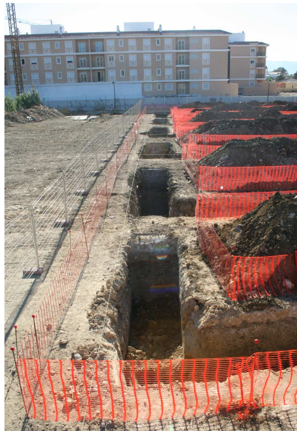
6.- Vista general de la Zanja 2 tomada desde el Este
