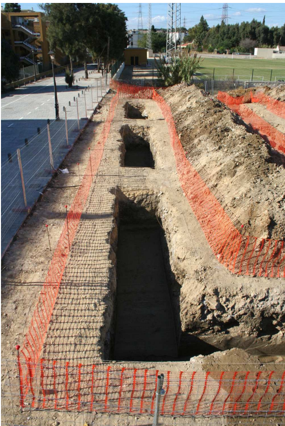
5.- Vista general de la Zanja 1 tomada desde el Este
