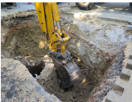
Lám. 1 proceso de excavación pozo 4
