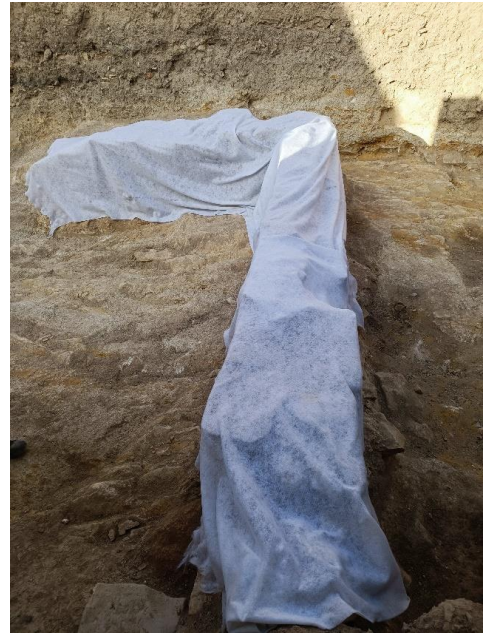
Foto 72. Cubrimiento de UE 6 con Geotextil
