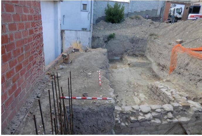
Foto 61. Planteamiento de Control de movimientos de tierra en zona muro por bataches
