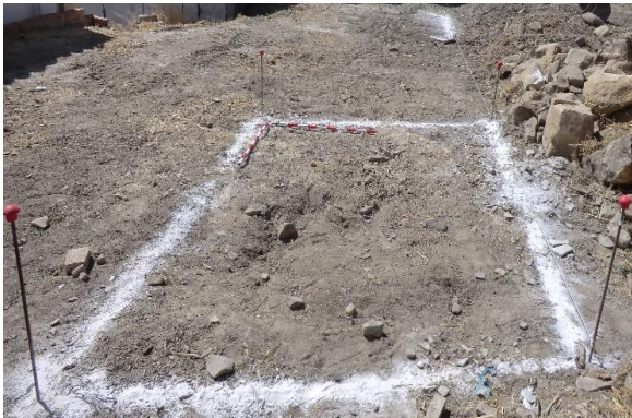
Foto 1. Planteamiento sondeo 1. US 1
