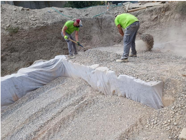
Foto 73. Cubrimiento estructuras UE 1 y 6 con grava
