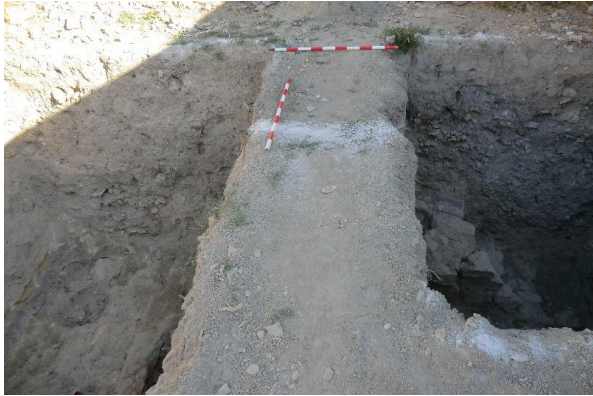
Foto 43. Inicio fase Control de movimientos de tierra. Retirada de testigo entre S1 Y 2
