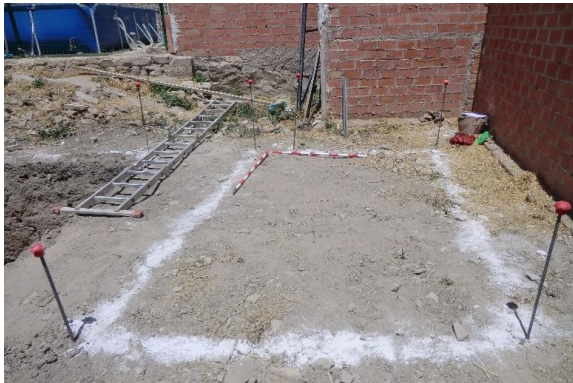
Foto 12. Planteamiento sondeo 2. US 1
