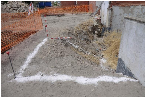
Foto 36. Planteamiento Sondeo 5. US 1
