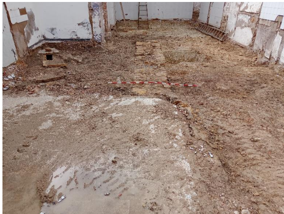
Foto 48. Vista general final de la parte Sur del solar
