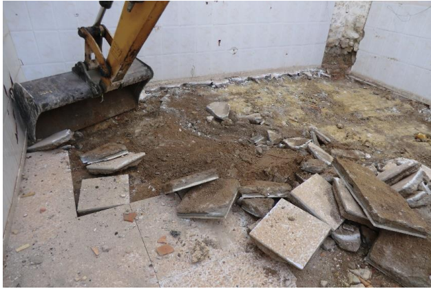
Foto 7. Retirada de UE 1 y UE 2
