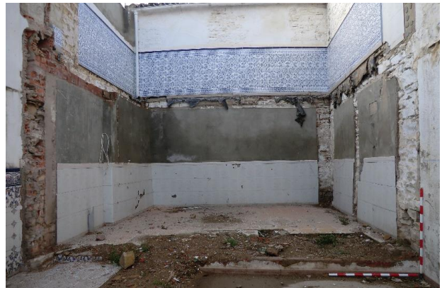
Foto 6. Desnivel en zona sur con respecto al resto de solar
