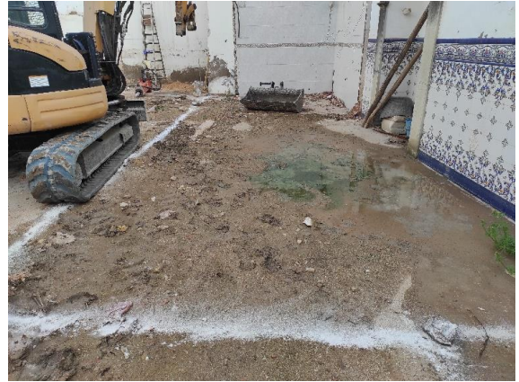
Foto 37. Área del patio que no se tocó. Zona sin excavar
