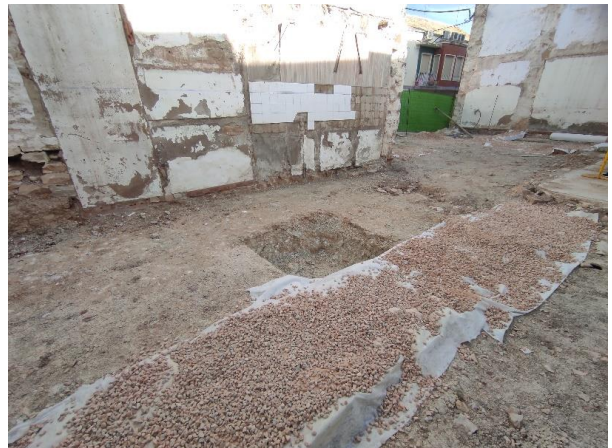
Foto 55. Cubrición de estructuras con geotextil y grava
