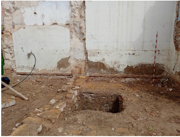
Foto 52. Perfil en la parte Norte del solar
