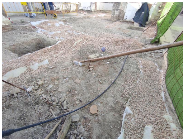
Foto 56. Vista general de todas las estructuras cubiertas con geotextil y grava
