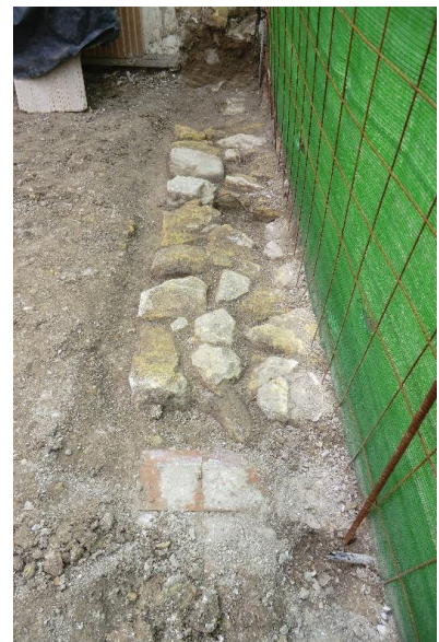
Foto 28. Detalle aparición de muro UE 10 (parte sur)
