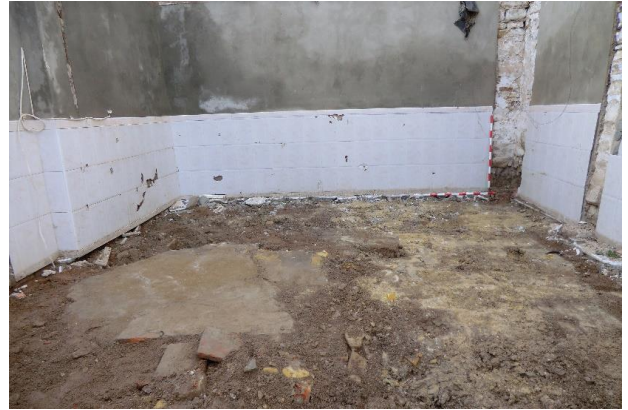
Foto 8. Vista de US 1, US 2, UE 3 y UE 4, al retirar UE 1 y 2.
