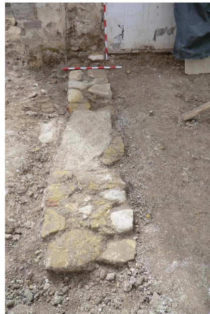
Foto 42. Detalle vista final de UE 6 (lado Sur)
