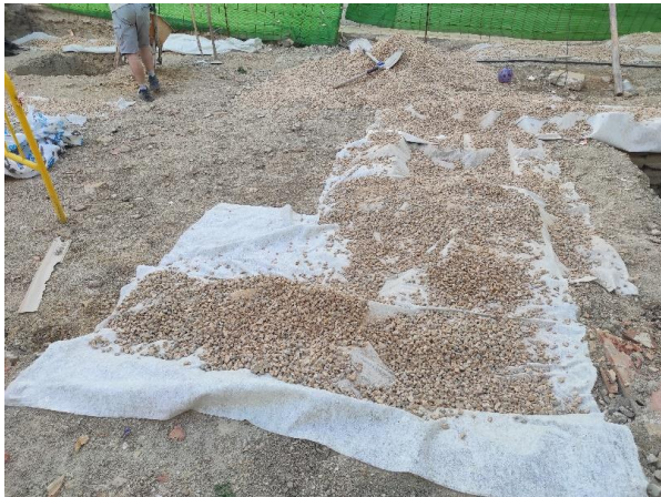
Foto 54. Cubrición de estructuras con geotextil y grava
