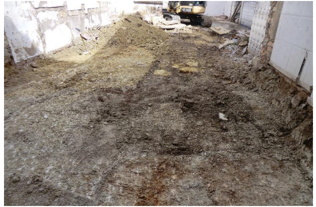
Foto 14. UES 9 y 1 retiradas y aparición de UE 5 y US 1 y 2
