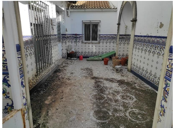
Foto 2. Detalle del patio interior. Única zona que no se vio afectada por la excavación y que se mantuvo a esa cota.
