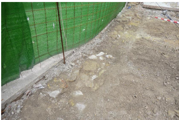
Foto 29. Detalle aparición de muro UE 10 (parte norte)
