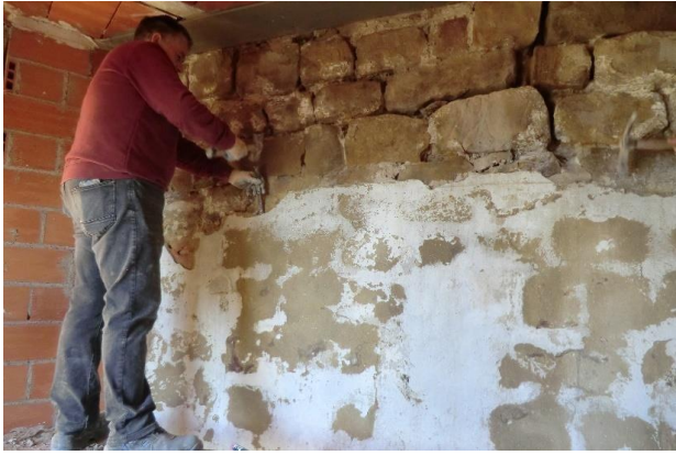
Foto 30. Retirada de la capa de pintura y yeso con medios manuales
