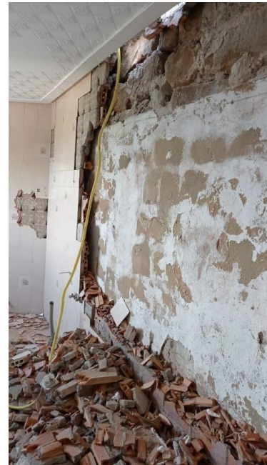
Foto 28. Retirada pared de ladrillo delante del tramo de muralla
