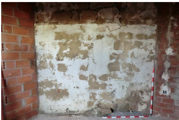
Foto 29. Estado inicial tramo de muralla en interior de la vivienda
