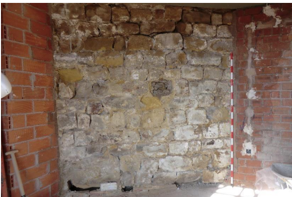
Foto 34. Muralla con ladrillos y cemento retirados dejando al descubierto rebajes en los sillares y huecos. Limpia
