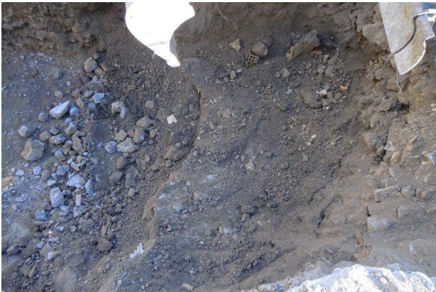
Foto 23. US 5 con escombros y piedras pequeñas
