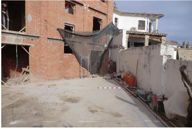
Foto 1. Planteamiento primera parte sondeo. UE 1
