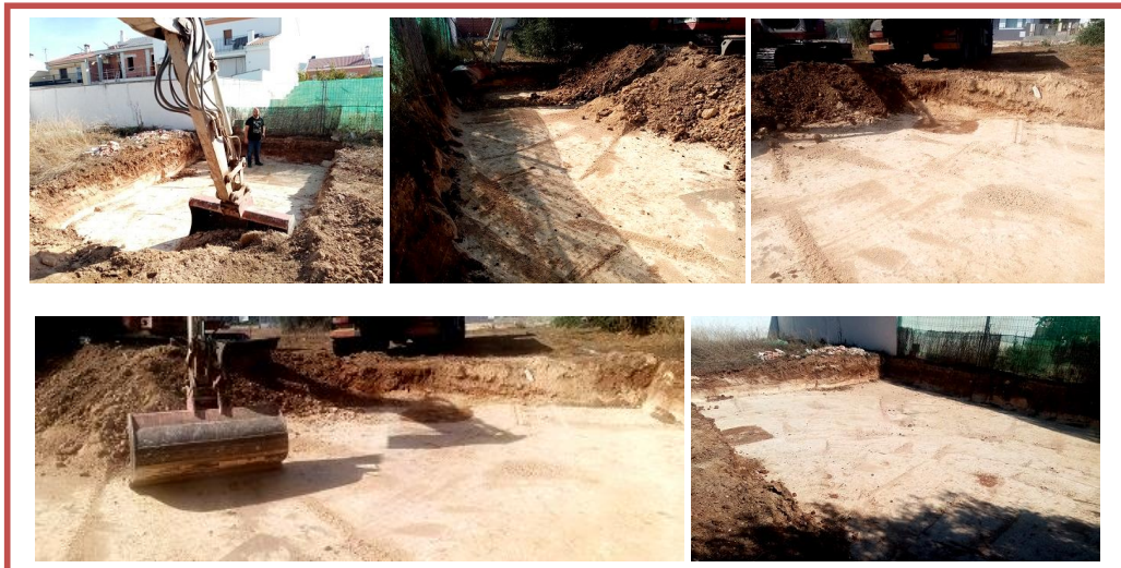
FIG. 10. ELIMINACIÓN DE LOS 15-20 CMS. MÁS SUPERFICIALES Y METEORIZADOS DE LA ROCA NATURAL DEL TERRENO EN LA ZONA DEL FONDO DEL SOLAR, DESTINADA A LA FUTURA PISCINA, DONDE SE OBSERVA COMO VAN DESAPARECIENDO LA MAYORÍA DE LAS HUELLAS EN NEGATIVO DE LAS CIMENTACIONES DE ALGÚN TIPO DE CONSTRUCCIÓN DE ÉPOCA CONTEMPORÁNEA (Fotos: J.A. Hermoso).
