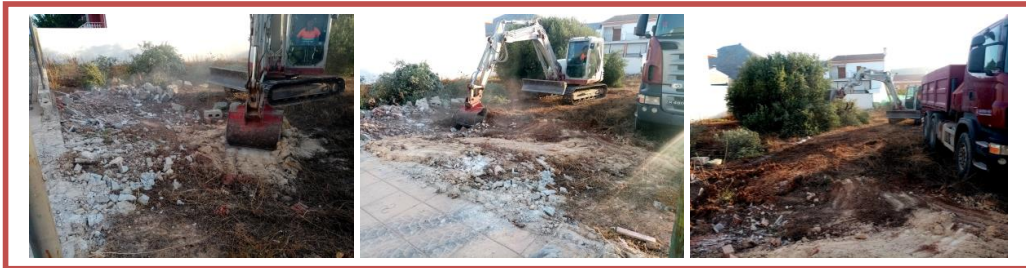
FIG. 7. ELIMINACIÓN DE PARTE DE LOS BLOQUES Y DE LA VALLA DE LA LÍNEA DE FACHADA DEL SOLAR Y PREPARACIÓN DEL ACCESO EN RAMPA AL INTERIOR DEL SOLAR POR LA MÁQUINA Y LOS CAMIONES (Fotos: J.A. Hermoso).
