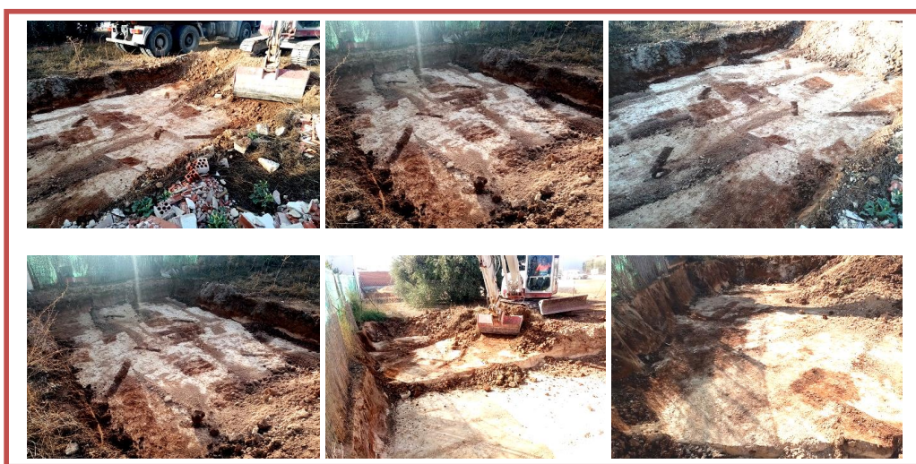
FIG. 9. HUELLAS EN NEGATIVO DE PEQUEÑAS ZANJITAS Y POZOS CUADRANGULARES DE CIMENTACIÓN EN LA ZONA DEL FONDO DEL SOLAR DESTINADA A LA FUTURA PISCINA, DE ALGÚN TIPO DE PRECARIA O PROVISIONAL CONSTRUCCIÓN DE ÉPOCA CONTEMPORÁNEA QUE OCUPÓ PREVIAMENTE EL SOLAR PARA ACTIVIDADES QUE NO HEMOS PODIDO DETERMINAR POR LA INEXISTENCIA DE ÍTEMS MATERIALES ASOCIADOS (Fotos: J.A. Hermoso).
