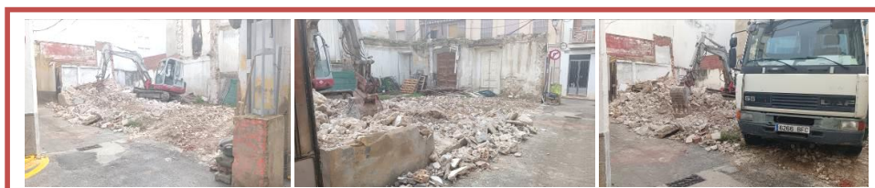
FIG. 12. PROCESO DE DERRIBO Y DESESCOBRO DE LA PARED DE FACHADA DE LA C/. SALSIPUEDES Y DE LAS PEQUEÑAS HABITACIONES EXISTENTES EN EL FONDO ORIENTAL DEL SOLAR (Fotos: JUAN ÁNGEL MARTOS HERMOSO).
