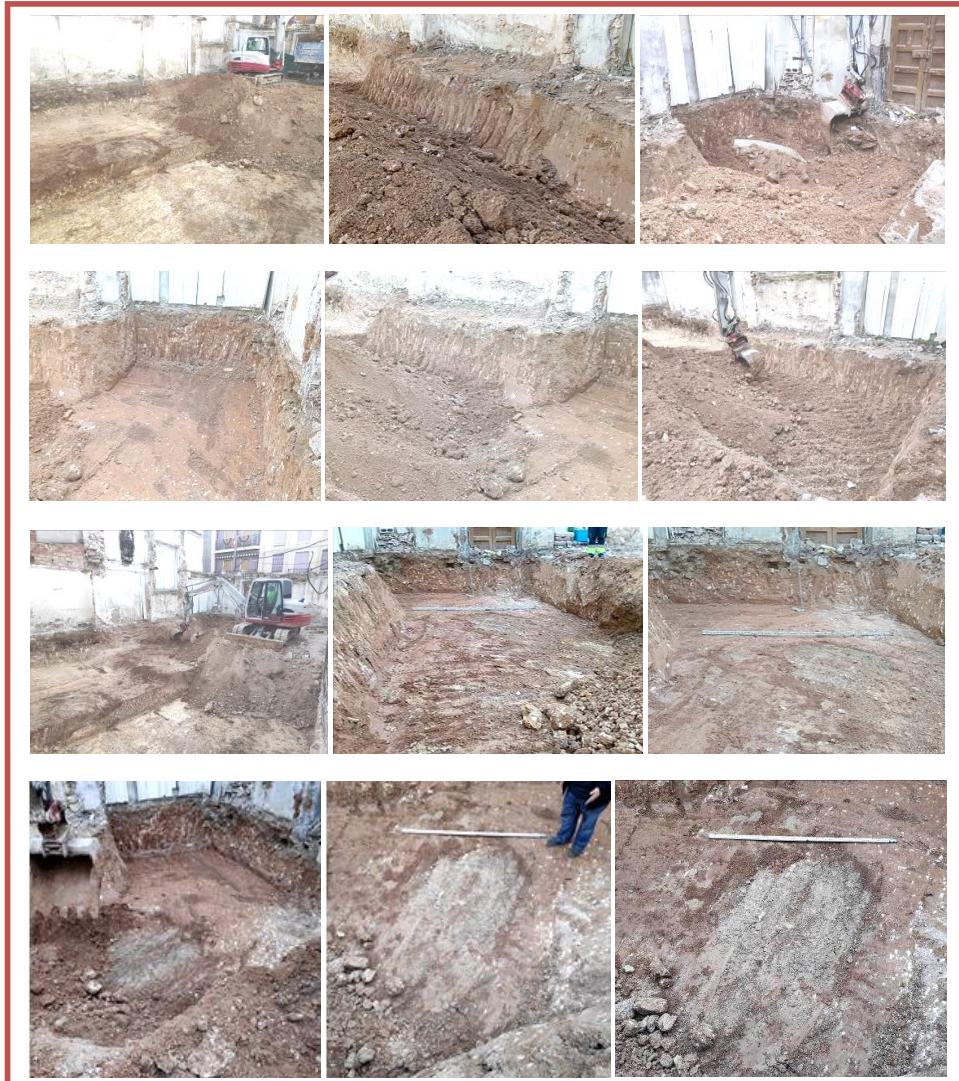
FIG. 19. FOTO PRIMERA: HUELLA DE PLANTACIÓN Y RAÍCES DEL ÁRBOL QUE HABRÍA EN EL PATIO INTERIOR DE LA ÚLTIMA VIVIENDA QUE OCUPÓ EL SOLAR; 6 FOTOS SIGUIENTES: TACÓN DE SEGURIDAD PARA LA PARED MERIDIONAL SIN DERRIBAR Y VACIADOS DEL ÁREA SUROCCIDENTAL DE LA PARCELA; FOTOS RESTANTES: HUELLA EN NEGATIVO DEL POZO CIEGO, DE RECOGIDA DE LAS AGUAS FECALES DE LA ÚLTIMA VIVIENDA QUE OCUPÓ EL SOLAR (FOTOS: JUAN ÁNGEL MARTOS HERMOSO).
