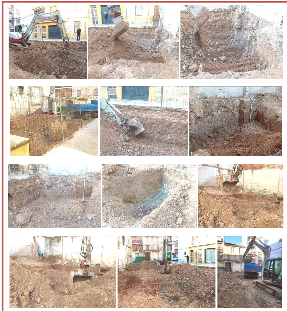
FIG. 15. CONTINUACIÓN DE LOS PROCESOS DE VACIADO DE LA ZONA CENTRO-ORIENTAL DEL SOLAR = LAS 7 PRIMERAS FOTOS: ZONA SURORIENTAL: FOTO 8: CATA EN PROFUNDIDAD PARA VALORAR LA COMPOSICIÓN DE LA MATRIZ GEOLÓGICA DEL TERRENO; FOTOS RESTANTES: ELIMINACIÓN DE LAS TIERRAS DEL SOLAR (FOTOS: JUAN ÁNGEL MARTOS HERMOSO).
