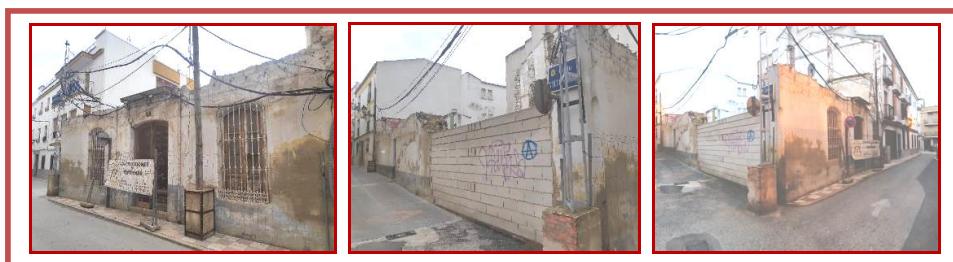
FIG. 10. ESTADO PREVIO DEL SOLAR. IZQU.: FACHADA POR LA C/. POSTIGUILLO; CENTRO: FACHADA POR LA C/. SALSIPUEDES; DRCHA.: PANORÁMICA DEL EXTERIOR DEL SOLAR (Fotos: JUAN ÁNGEL MARTOS HERMOSO).
