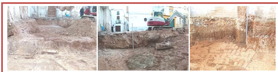
FIG. 20. IZQU.: ÚLTIMOS VACIADOS JUNTO A LA ESQUINA NOROCCIDENTAL DEL SOLAR; CENTRO: POZO CIEGO Y TACÓN DE TIERRAS SIN VACIAR PARA LA RAMPA DE ACCESO AL INTERIOR DEL SOLAR; DRCHA: RESTOS PARCIALES DE UN POZO DE CIMENTACIÓN DE UN PILAR DE LA PARED ORIENTAL DE LA ÚLTIMA VIVIENDA QUE OCUPÓ EL SOLAR (FOTOS: JUAN ÁNGEL MARTOS HERMOSO).
