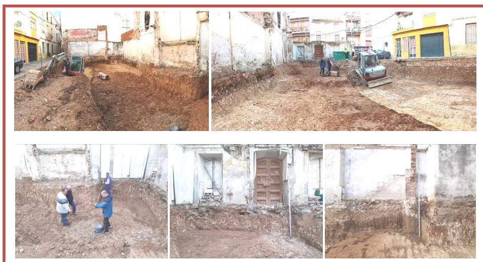
FIG. 21. ESTADO FINAL DE LOS VACIADOS DEL SOLAR Y TOMA DE MEDICIONES (FOTOS: JUAN ÁNGEL MARTOS HERMOSO).
