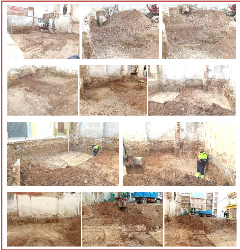
FIG. 17. CONTINUACIÓN DE LOS PROCESOS DE VACIADO EN LA ZONA SURORIENTAL/CENTRO-MERIDIONAL DEL SOLAR HASTA LAS COTAS NECESARIAS PARA LA IMPLANTACIÓN DE LA NUEVA CIMENTACIÓN PROYECTADA (FOTOS: JUAN ÁNGEL MARTOS HERMOSO).
