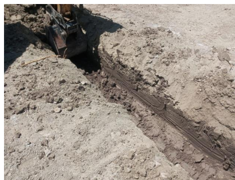
Encepados en zona oeste
