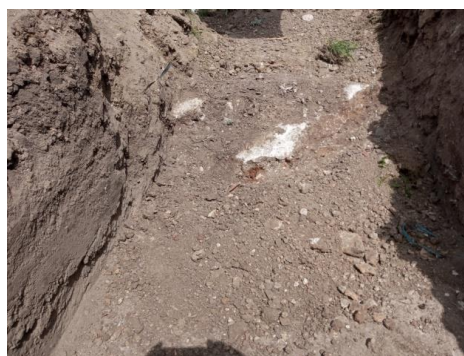
Bloque de hormigón (UE 1).
