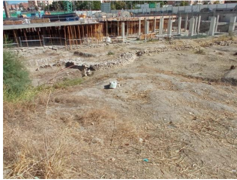
Parcela tras su desbroce. Vista desde norte.
