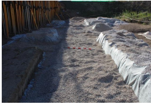
Proceso de cubrición con malla geotextil y grava de los restos arqueológicos.
