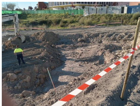
Proceso de relleno de zona norte del solar
