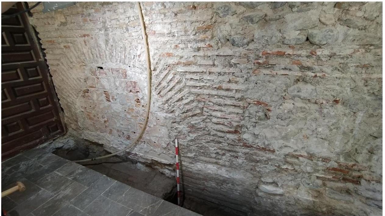
Ilustración 15: Alzado de uno de los muros de tapial.
