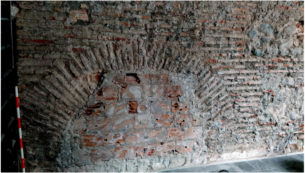
Ilustración 3: Arco de un aljibe bajo el suelo
