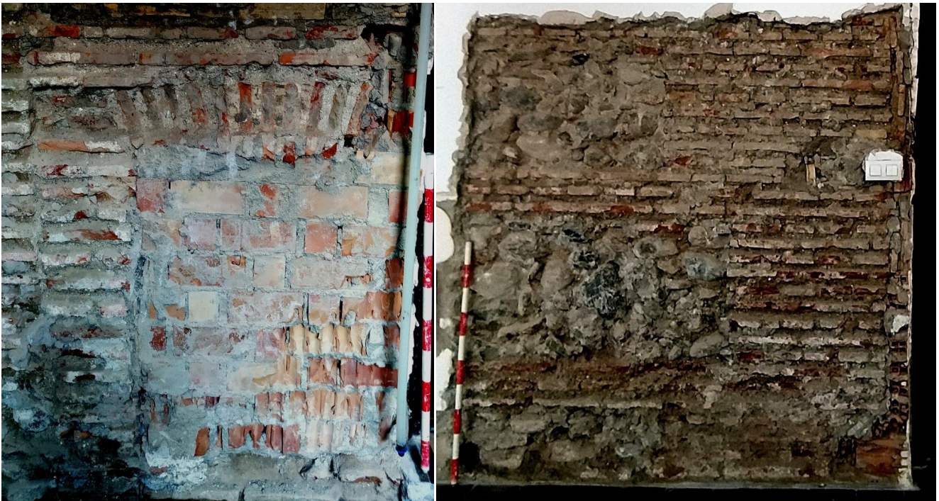
Ilustración 4: Vano enmarcado con dintel de ladrillo en cuña.
