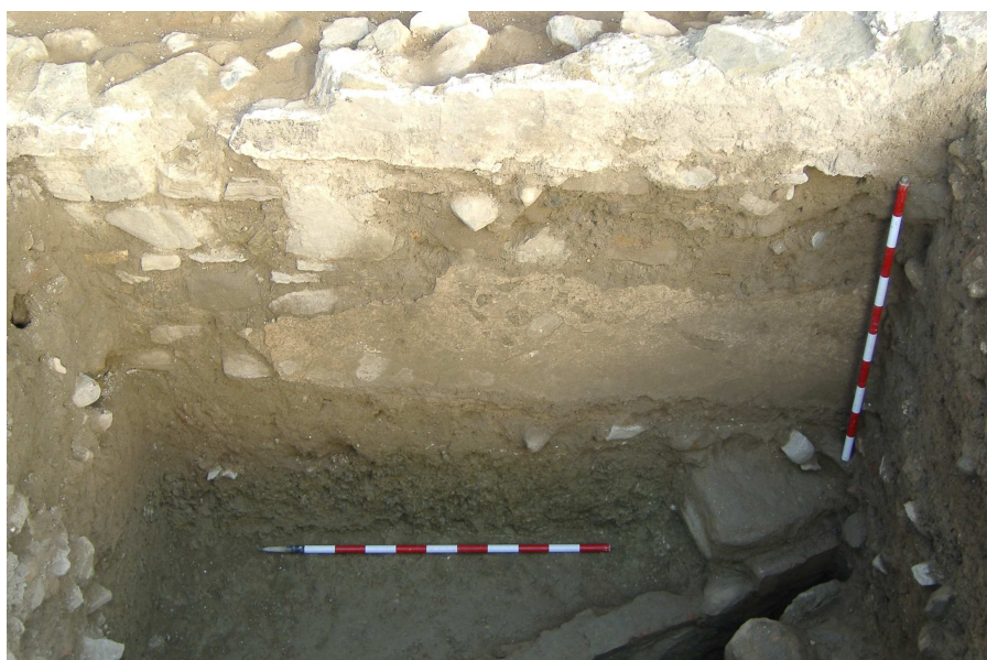
Lam. II. Revestimiento lienzo muralla
