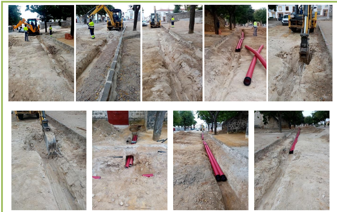
FIG. 10. APERTURA DE OTRO TRAMO DE LA ZANJA PRINCIPAL DE UNOS 20 METROS DE LONGITUD LINEAL DESDE LA TERCERA DE LAS ZANJAS LATERALES HASTA EL SIGUIENTE DE LOS POZOS CUADRANGULARES PARA LA INSTALACIÓN DE OTRA DE LAS ARQUETAS DE REGISTROS Y PRESENTACIÓN DE LOS TUBOS NECESARIOS (Fotos: Rafael Sánchez).
