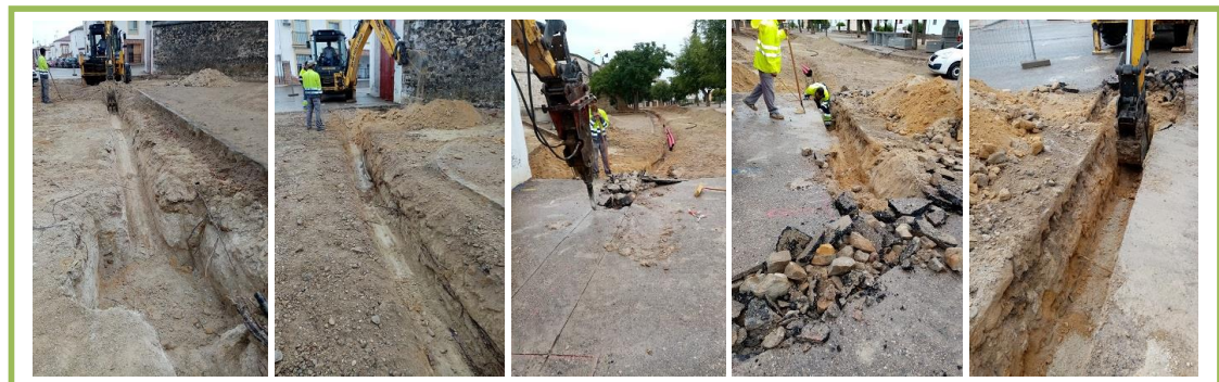
FIG. 11. APERTURA DEL ÚLTIMO TRAMO DE LA ZANJA PRINCIPAL Y DEL ÚLTIMO DE LOS POZOS CUADRANGULARES NECESARIOS PARA LA INSTALACIÓN DE LA ARQUETA DE REGISTRO EN LA INTERSECCIÓN ENTRE LAS CALLES SIERRA DE SEGURA Y SOR FELISA ANCÍN (Fotos: Rafael Sánchez).
