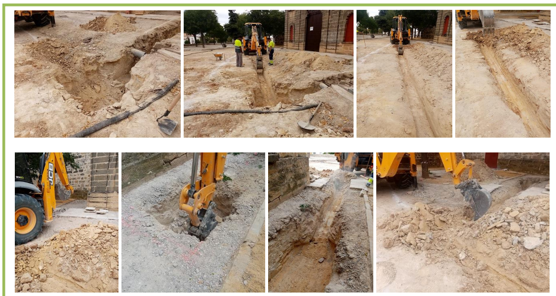
FIG. 7. APERTURA DEL PRIMER TRAMO DE LA ZANJA PRINCIPAL EN PARALELO A LA PORTADA DE LA PLAZA DE TOROS Y APERTURA DE LA ZANJA LATERAL Y DE DOS POZOS CUADRANGULARES, PARA ARQUETAS DE REGISTRO, EN EL FLANCO NOROESTE DE ESA PORTADA (Fotos: Rafael Sánchez).
