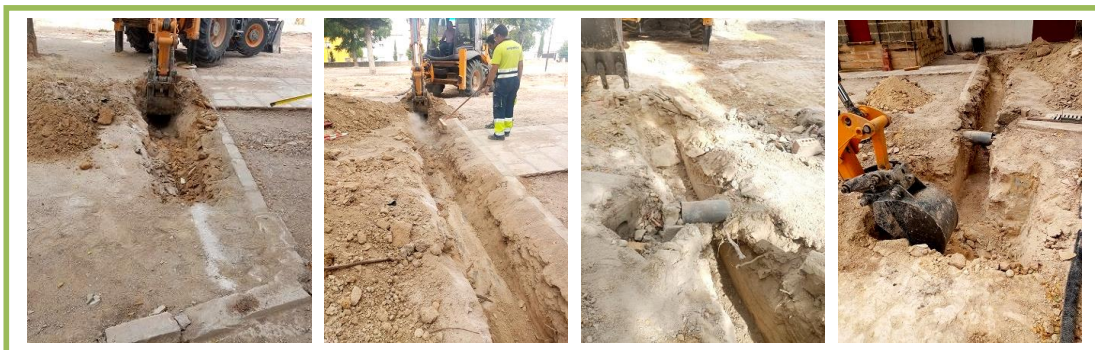
FIG. 6. APERTURA DE LA PRIMERA ZANJA LATERAL EN EL FLANCO SUROESTE DE LA PORTADA PRINCIPAL DE LA PLAZA DE TOROS Y DEL PRIMER POZO CUADRANGULAR PARA UNA ARQUETA DE REGISTRO DE LA NUEVA ACOMETIDA ELÉCTRICA EN EL EXTREMO NOROESTE DE LA ZANJA (Fotos: Rafael Sánchez).
