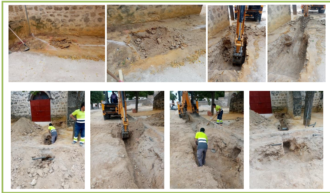
FIG. 9. APERTURA DE LA TERCERA DE LAS ZANJAS LATERALES Y DE LOS POZOS CUADRANGULARES PARA LA INSTALACIÓN DE LAS DOS ARQUETAS DE REGISTROS DE SUS EXTREMOS, DONDE EL BANCO DE ROCA NATURAL SEGÚA BUZANDO EN PENDIENTE HACIA EL NORESTE (Fotos: Rafael Sánchez).
