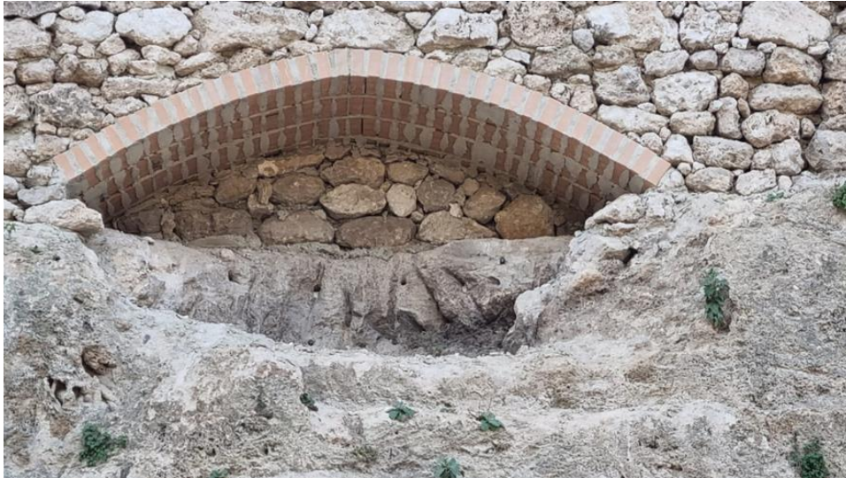
Fig. 8. Imagen de la integración de la estructura negativa bajo el muro perimetral reconstruido.
