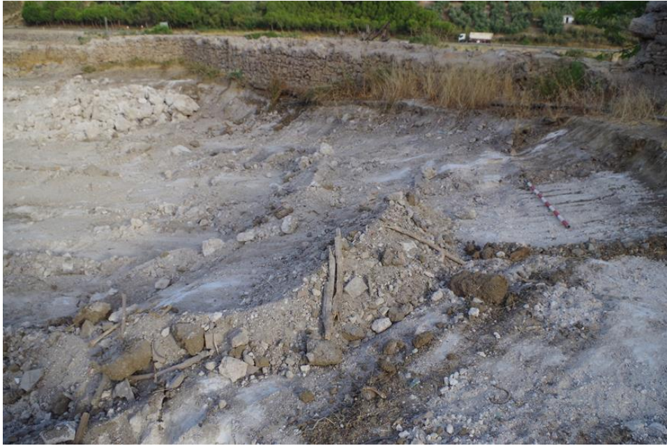
Fig. 6. Rebase del solar, directamente sobre el geológico.
