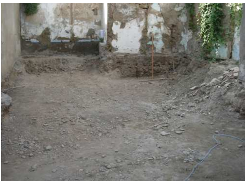
Lámina VIII. Vista general del solar ya rebajado.
