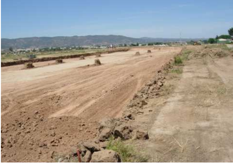
Lámina VII. Vista general desde el Sur del área correspondiente a la nueva plataforma.
