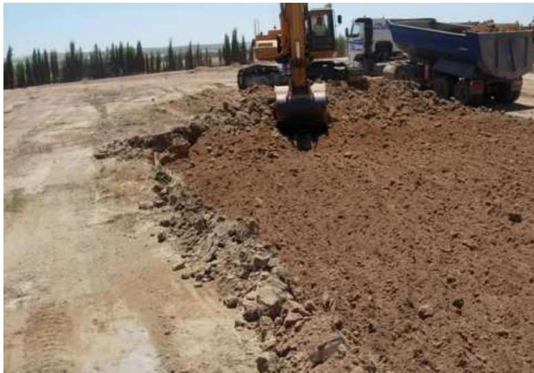
Lámina V. Proceso de excavación de la zona meridional de la nueva plataforma
