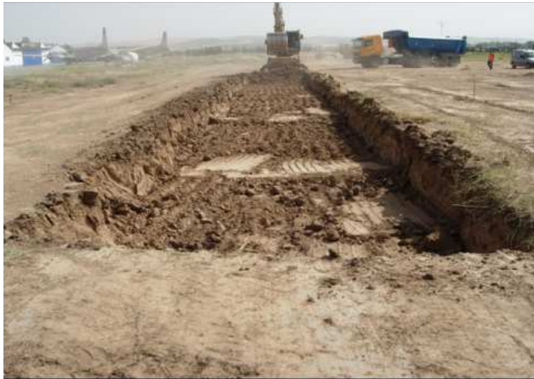
Lámina IV. Proceso de excavación de la zona central de la nueva plataforma
