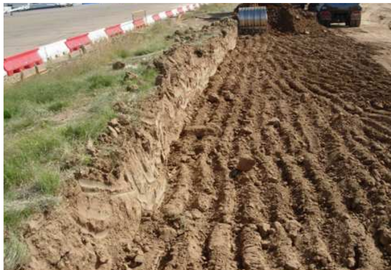
Lámina III. Proceso de excavación de la zona oriental de la nueva plataforma.
