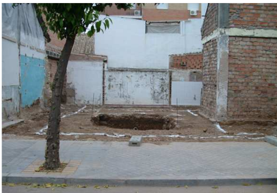
Lámina II. Vista del replanteo para la ampliación.
