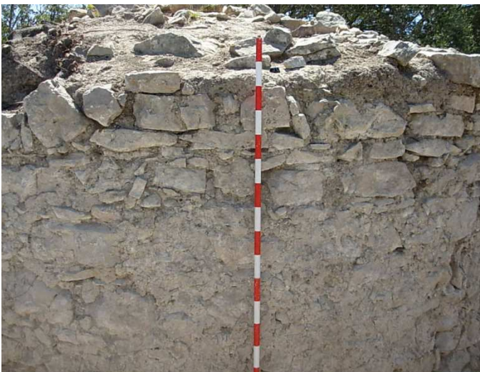
LÁM. II. Detalle de mampostería y mortero de cal que cubría la estructura.
