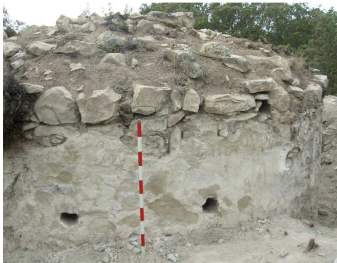
LÁM. IV. Lado E de la torre. Enlucido y Mechinales.
