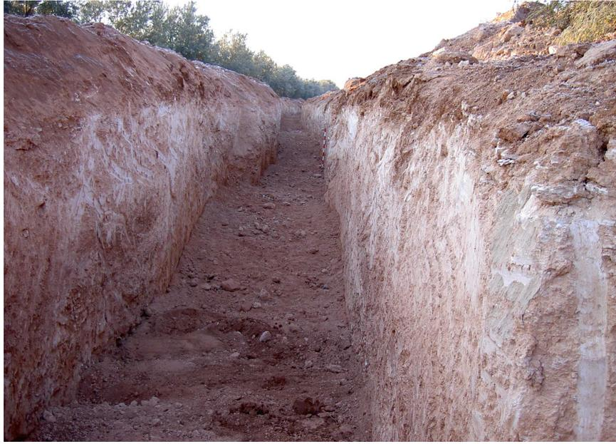
Lámina VII. Zanja en AL-03. La tierra del fondo cubre a la tubería ya insertada.
