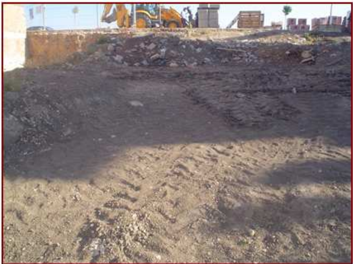
Lámina I.- Vista del estado previo del solar
