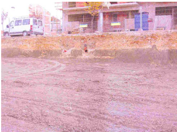
Lamina 2. Vaciado de las parcelas.
