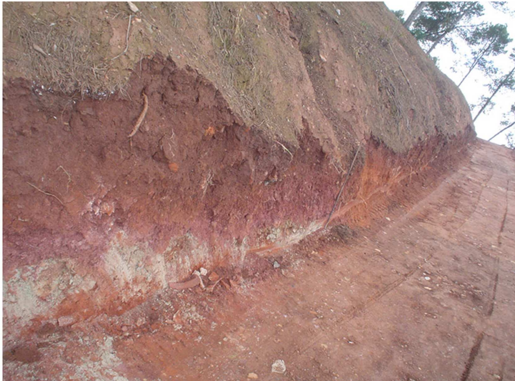
lám. II: Labores de desmonte del camino (tramo 3).
