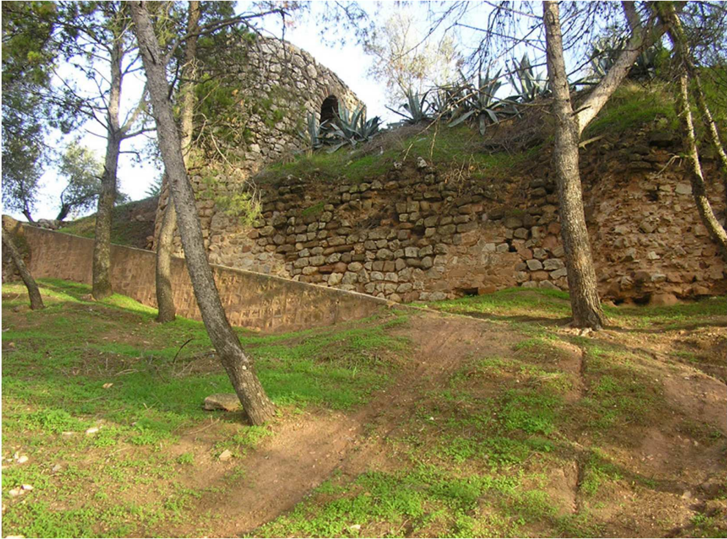
lám. I: Estado previo del terreno.
