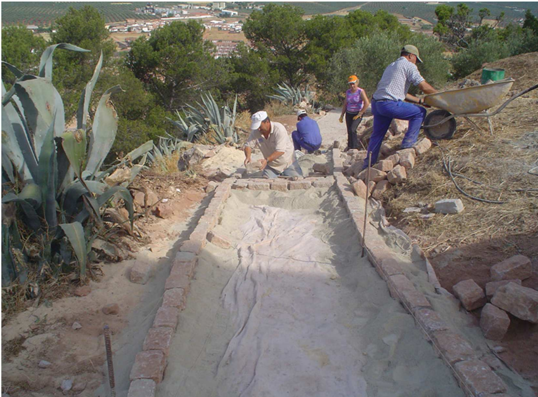
lám. VI: Colocación de la malla geotextil.
