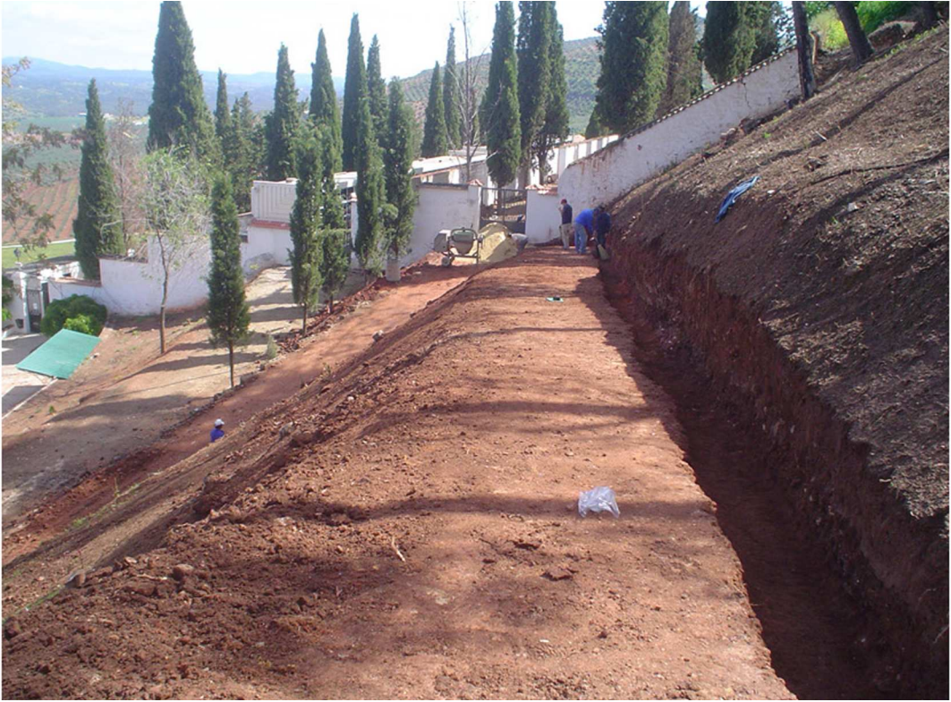
lám. III: Labores de desmonte del camino (tramo 3).
