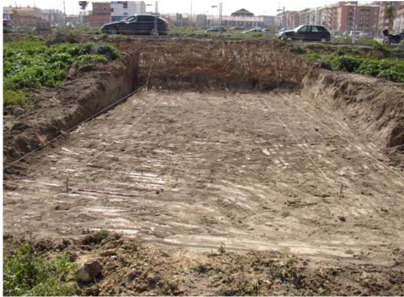
Lám. I. Vista de la parcela desde el Norte. Excavación a cota de cimentación.
