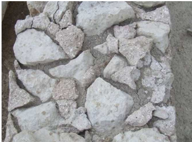
Fig. 6. Restos de revestimiento de muro divisorio
