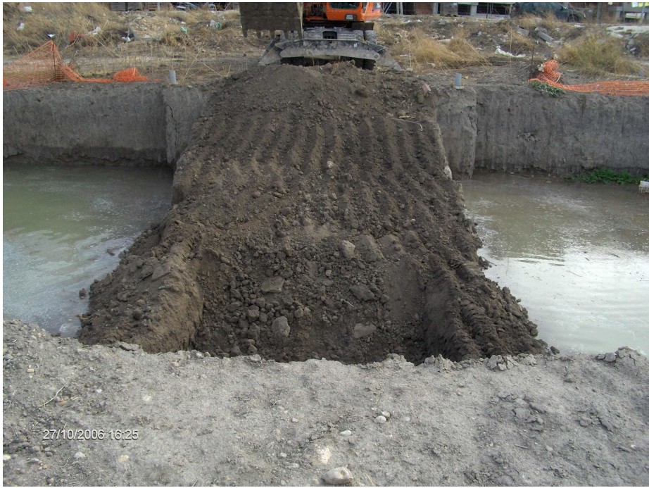
lám. I. Trabajos de excavación en el solar y vista de solares colindantes
