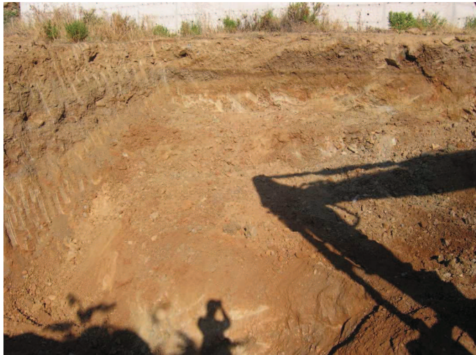
Lámina IV. Termino de los trabajos con maquinaria.
