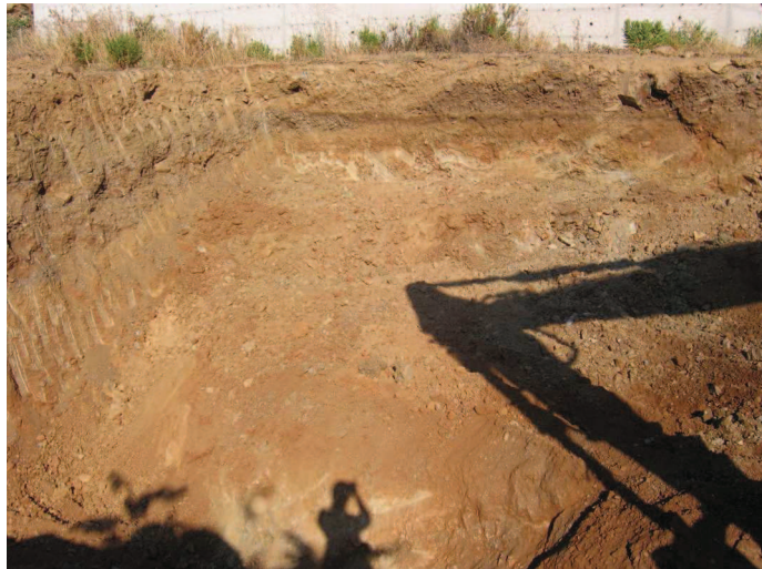
Lámina II. Seguimiento de los trabajos de los destierros vertidos en la parcela.
