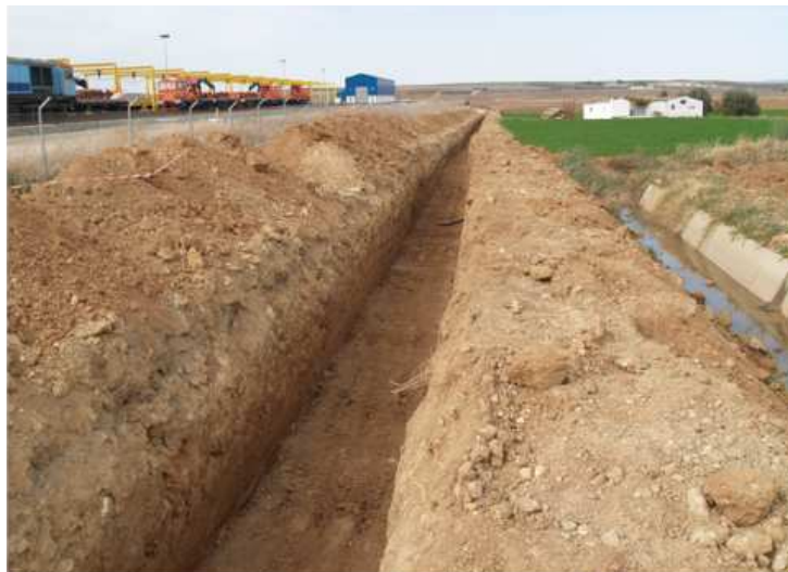
Lám. X. La zanja junto a la base de montaje
