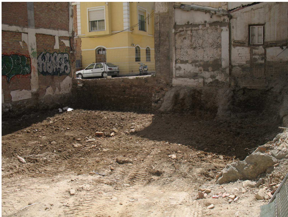
Lámina III. Rebaje completo del solar
