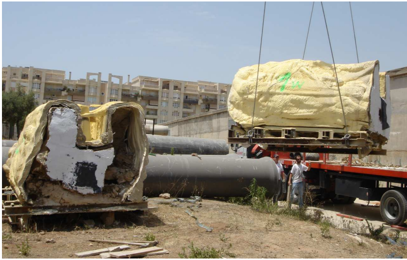
Fig. 6- Estado del tramo 2 tras su extracción y traslado a las instalaciones de EMASA
