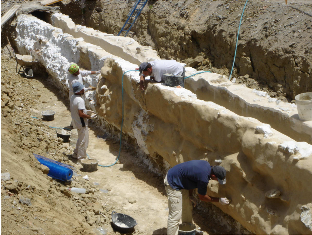
Fig. 1- Tratamientos de Consolidación
