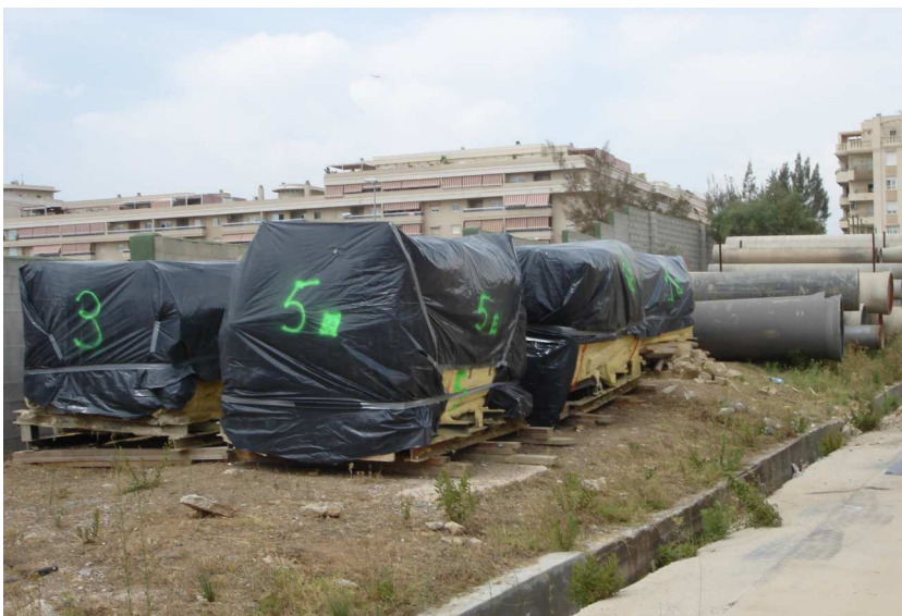
Fig. 7- Situación de los tramos extraídos en las instalaciones de EMASA
