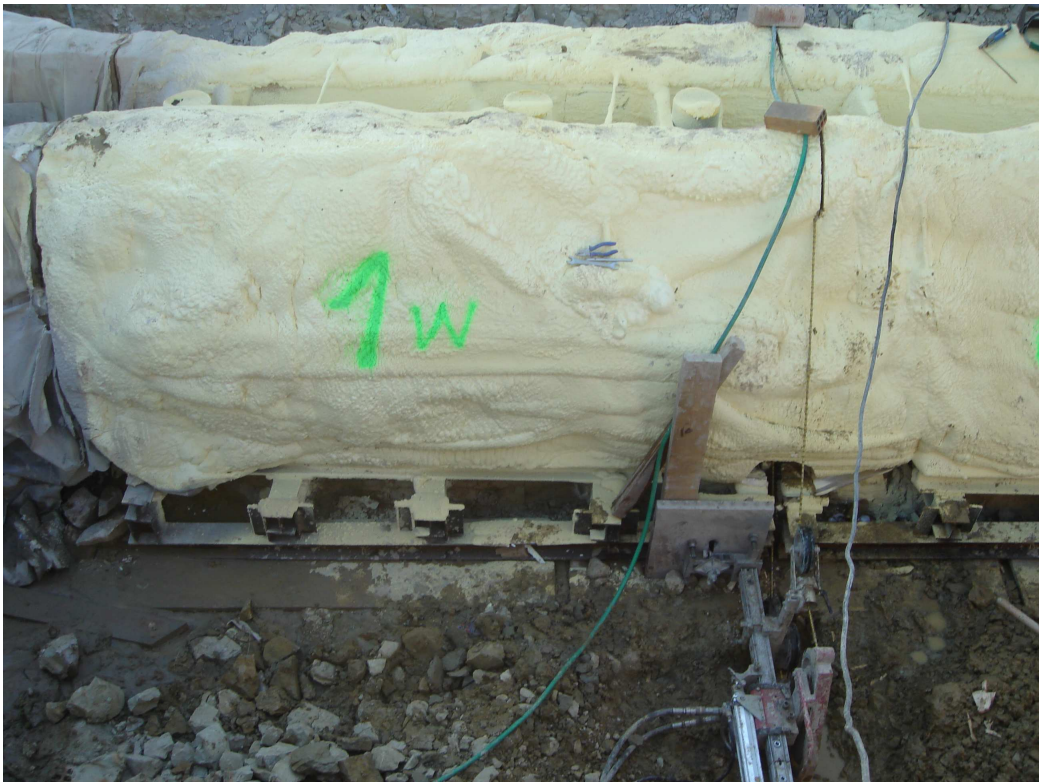
Fig. 3- Ejecución de cortes en el primer tramo 1W, se observa el estado final tras los trabajos de embalaje y conservación con cubrición de una capa de poliuretano
