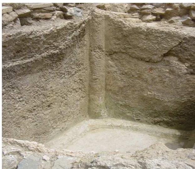
Lámina XII. Detalle de las esquinas de las piletas con la media caña.
