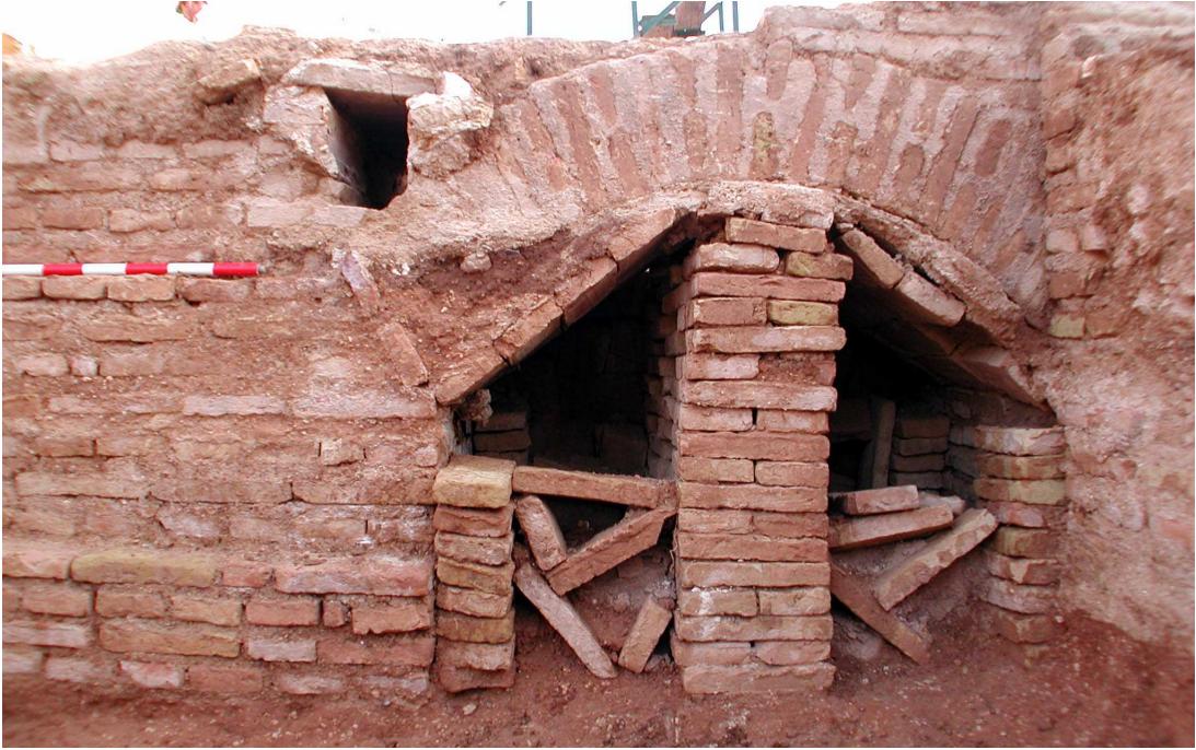
Lámina V. Corte 3. Vista frontal de la cimentación del claustro de Levante, construido a principios del siglo XVI, en la cual se inserta un arco de ladrillos de un posible respiradero que nunca llegó a ser habilitado, como prueba el hecho de que el formero de ladrillos utilizado para su construcción no fue retirado en ningún momento.
