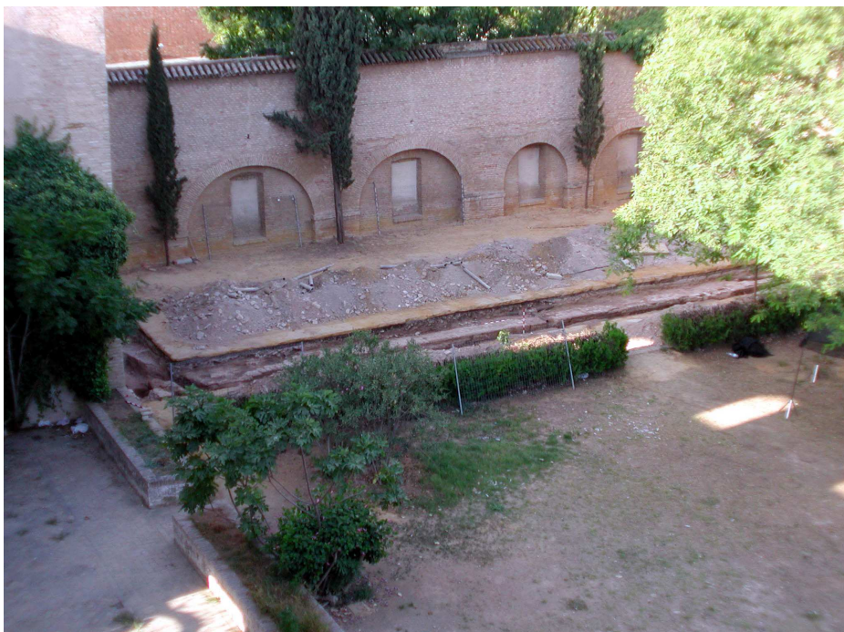
Lámina II. Vista general del muro de cierre sur, junto al que se sitúa el Corte 2. Dicho muro se conserva en alzado y en él destacan grandes vanos rematados en arcos de medio punto.
