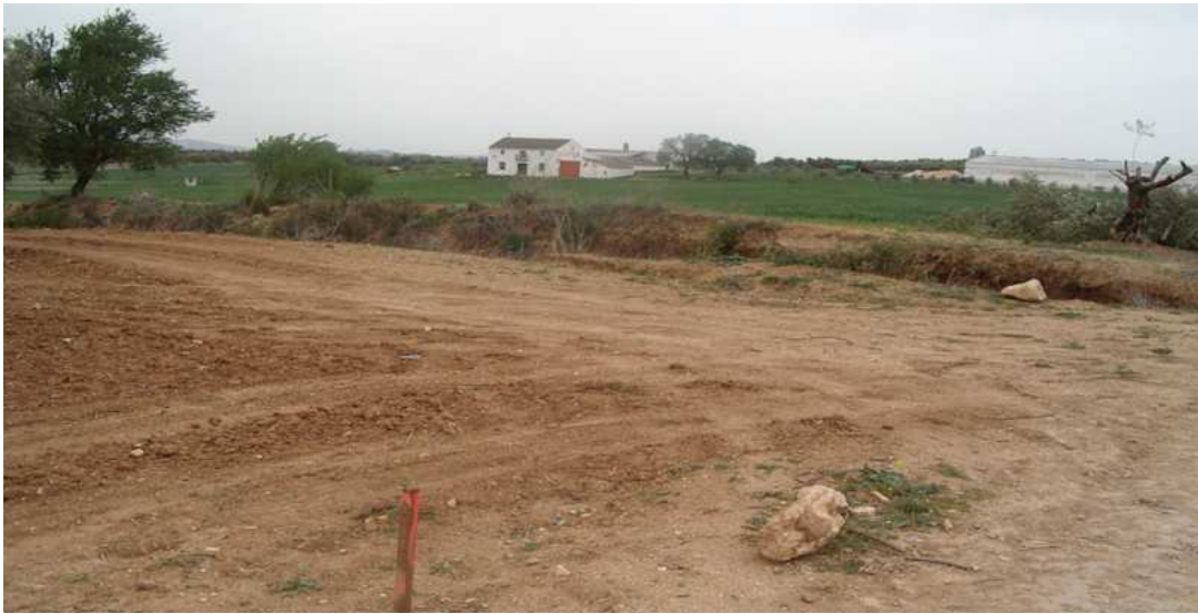
lám. I. Entidad 1, Entorno del yacimiento Fuente La Higuera. Vista general de la zona tras el desbroce de tierra vegetal
