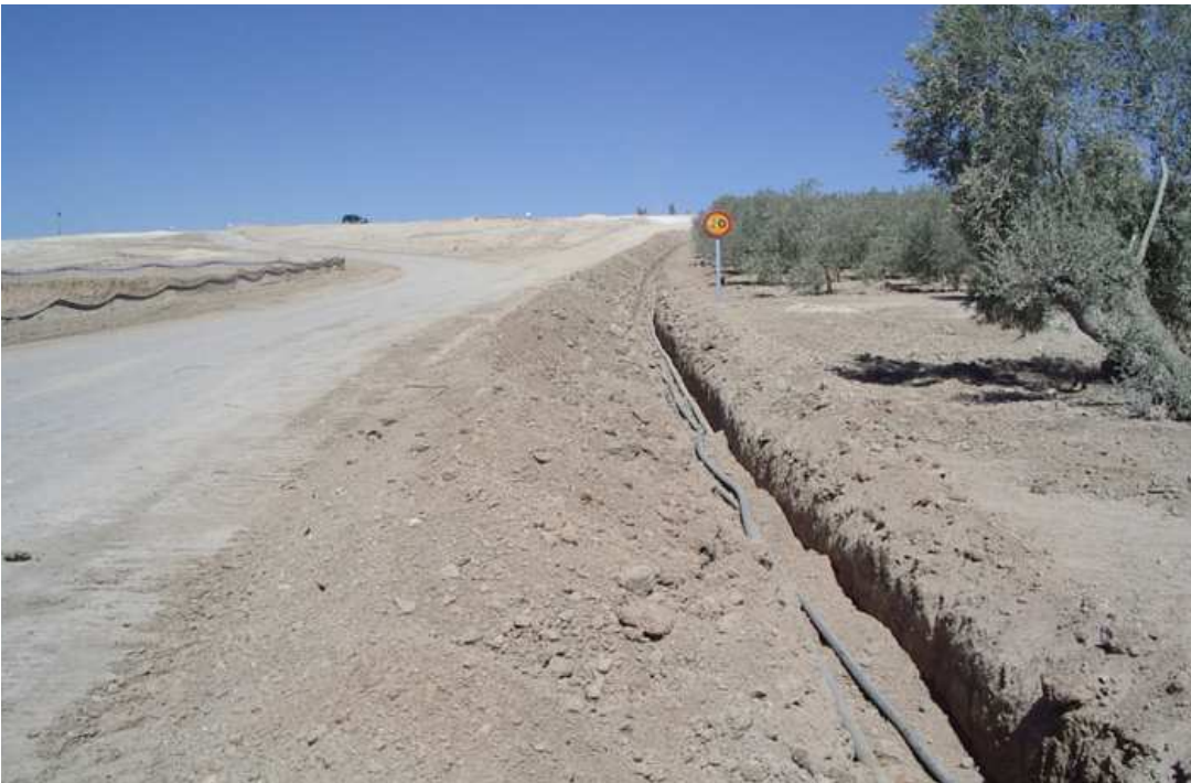
lám. VI. Entidad III, detalle de la excavación de las zanjas para cableado eléctrico.
