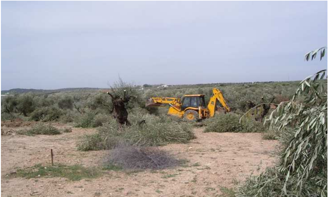
lám. IV. Fotografía de la zona donde se ubica la entidad III durante las labores de destoconado de olivos.
