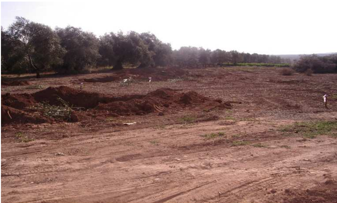
lám. II. Entidad 1. Vista tras el desmonte para construcción de apeos de negativos y forjados.
