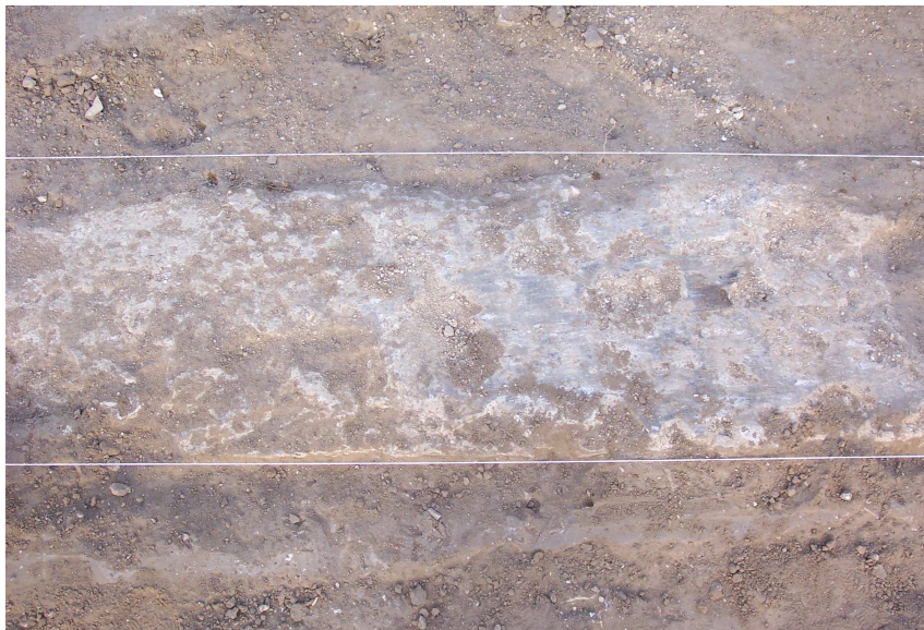
Lám. II: Detalle de uno de los cimientos de tapial.
