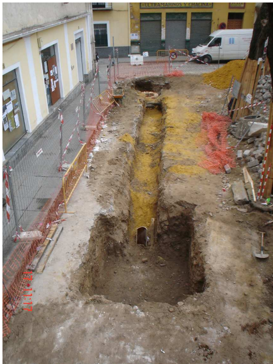
Lám. I. Sondeos A y B y Zanja 1
