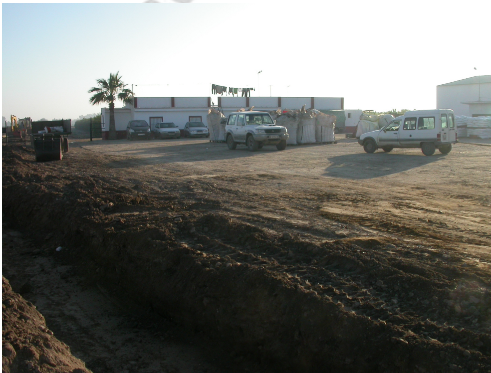
Figura 14. Vista del trazado de la zanja y de las construcciones actuales de la finca. (día 13.02.08)
