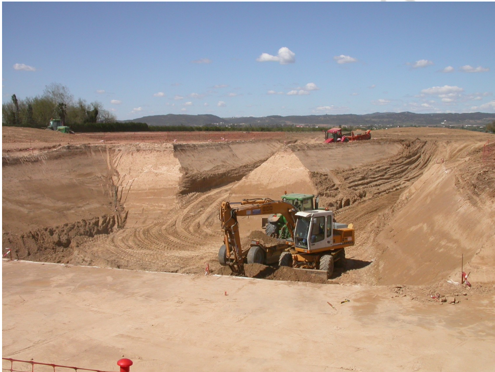
Figura 2. Vista del proceso de construcción de la Balsa 1.
