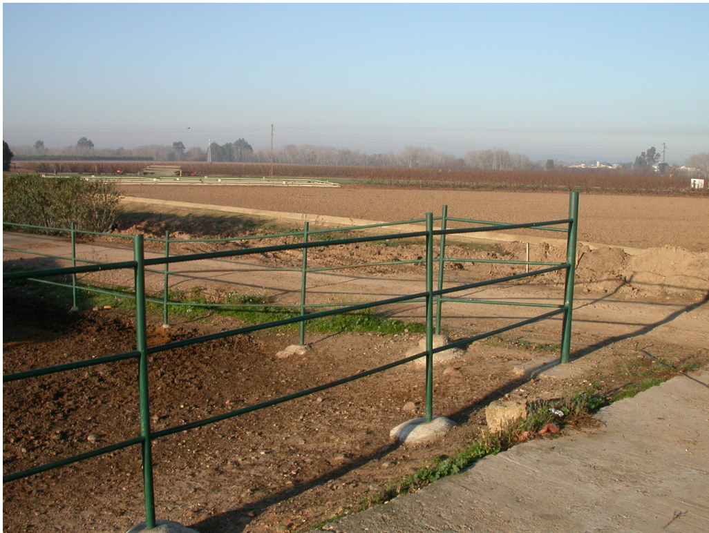
Figura 13 Vista general de la zona donde se desarrolla la zanja. Al fondo vemos en recorrido de la misma, en la parte más cercana se puede apreciar las construcciones contemporáneas. Suelo de hormigón. (día 13.02.08)
