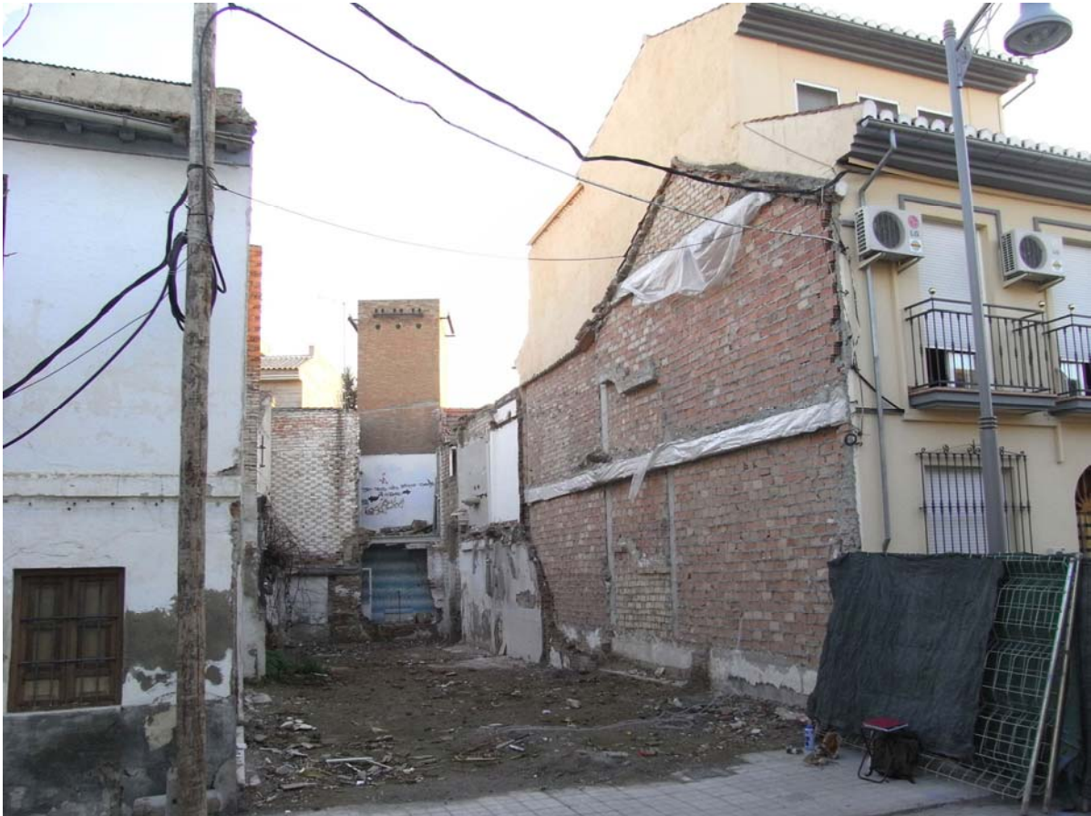
Lámina 1. Vista del solar antes de la actuación.
