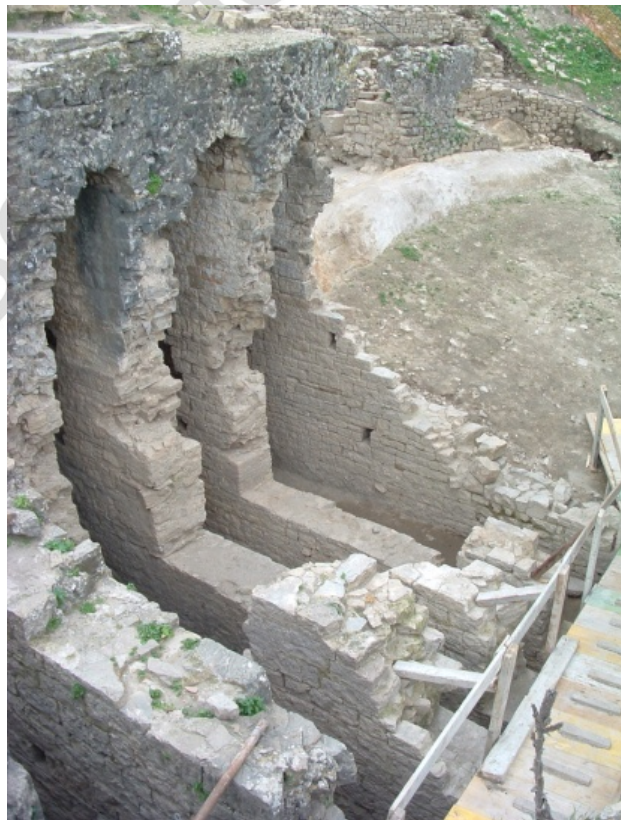
Fig.12. Vista de las bóvedas del basamento.
