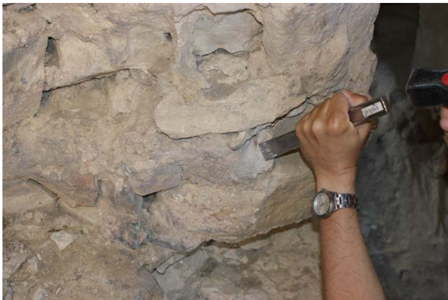
Fig. 15. Toma de muestras del mortero de fábrica del basamento de uno de los arcos de bóveda
