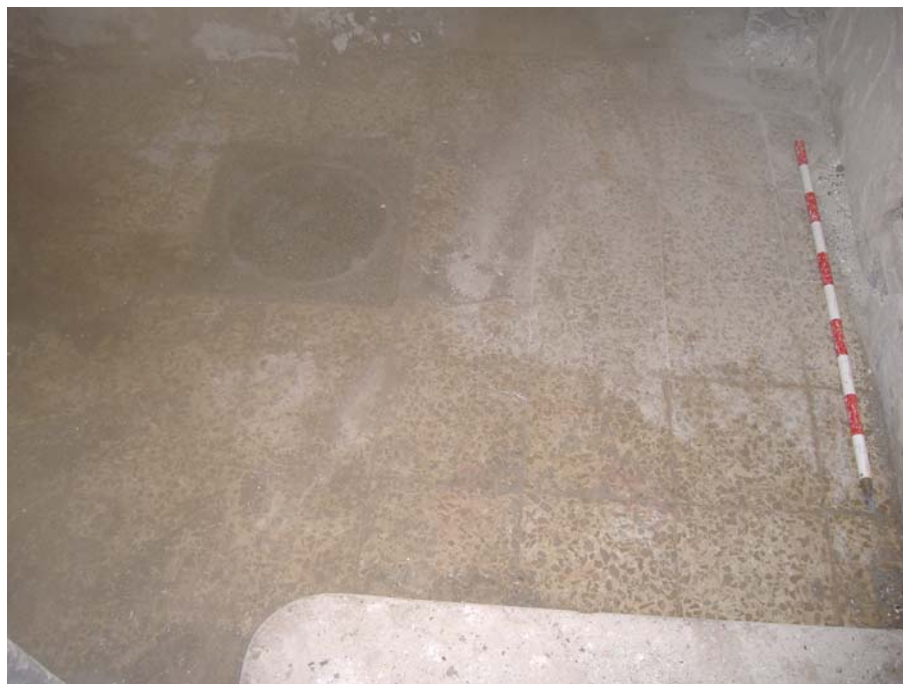
Figura 1 Aspecto inicial del lugar para hueco de ascensor
