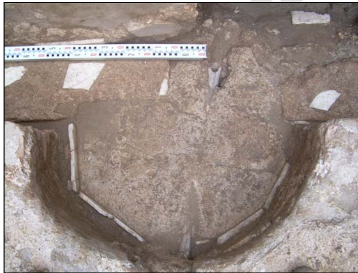
Lámina 8. Detalle de las tuberías de plomo en el semicírculo norte y parte sur de la fuente o U.e. 118.
