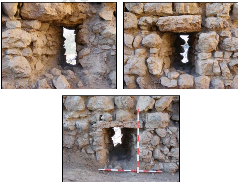
Lámina 6. Detalle de las tres saeteras exhumadas en el muro de cierre meridional.
