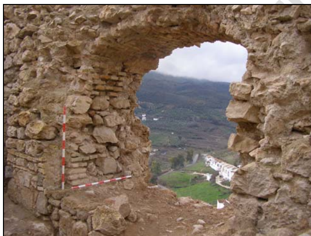
Lámina 5. Detalle de la puerta de acceso por el muro de cierre meridional.
