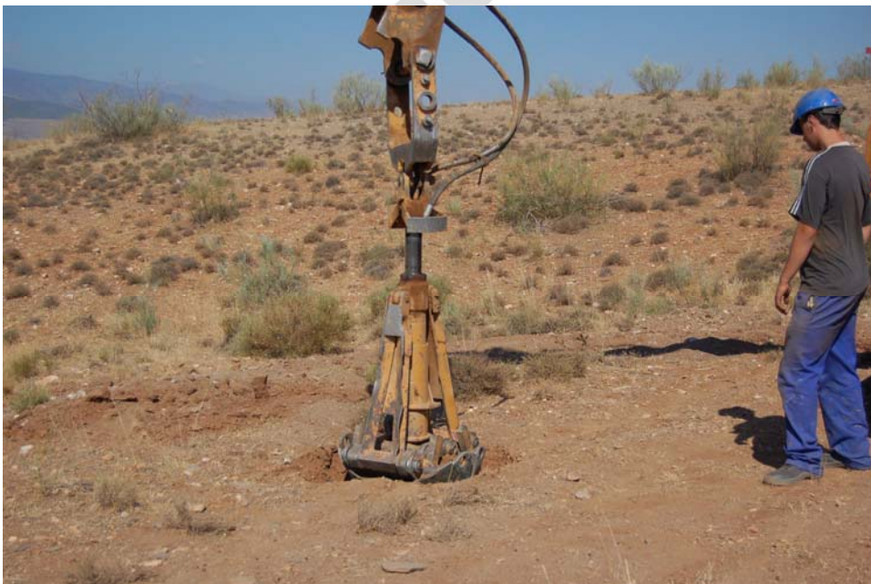
Figura 1. Trabajos en el apoyo nº 4
