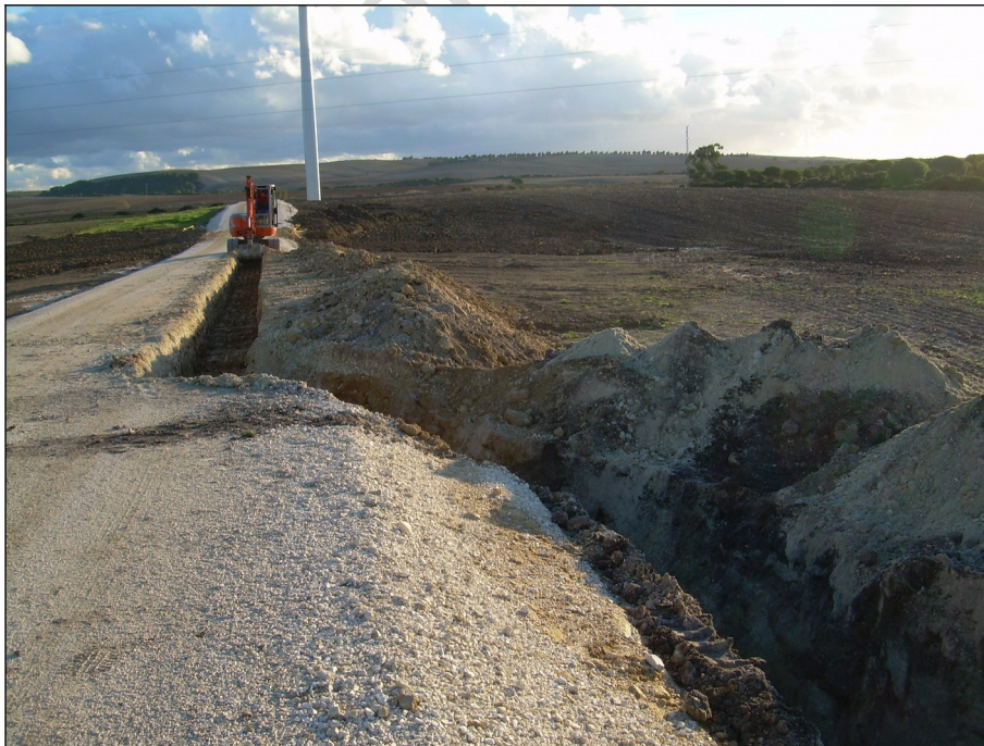
Lámina III. UUII. 12 Y 42. Yacimiento arqueológico “Malas Noches I”. Excavación de la zanja de cableado sobre el vial elevado artificialmente (1488).
