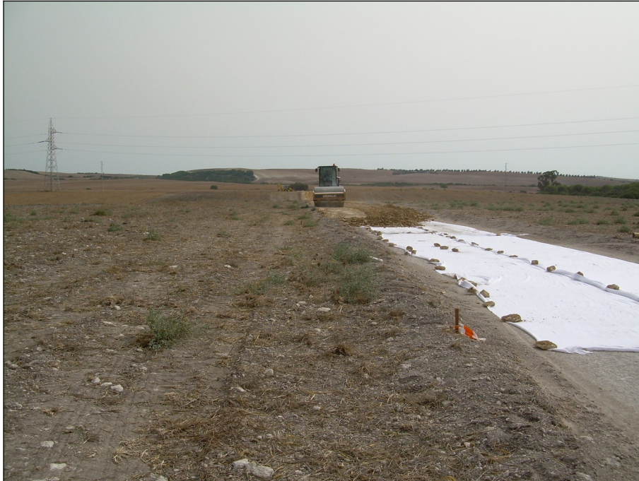
Lámina II. UI. 12. Yacimiento arqueológico “Malas Noches I”. Proceso de elevación artificial del vial mediante aporte de tierra, para evitar afección al yacimiento (526).
