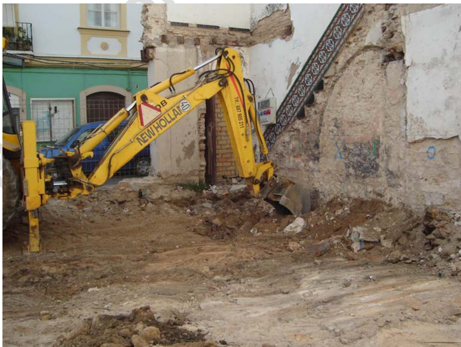
Lámina 2. Vista general. Proceso de realización de los bataches.
