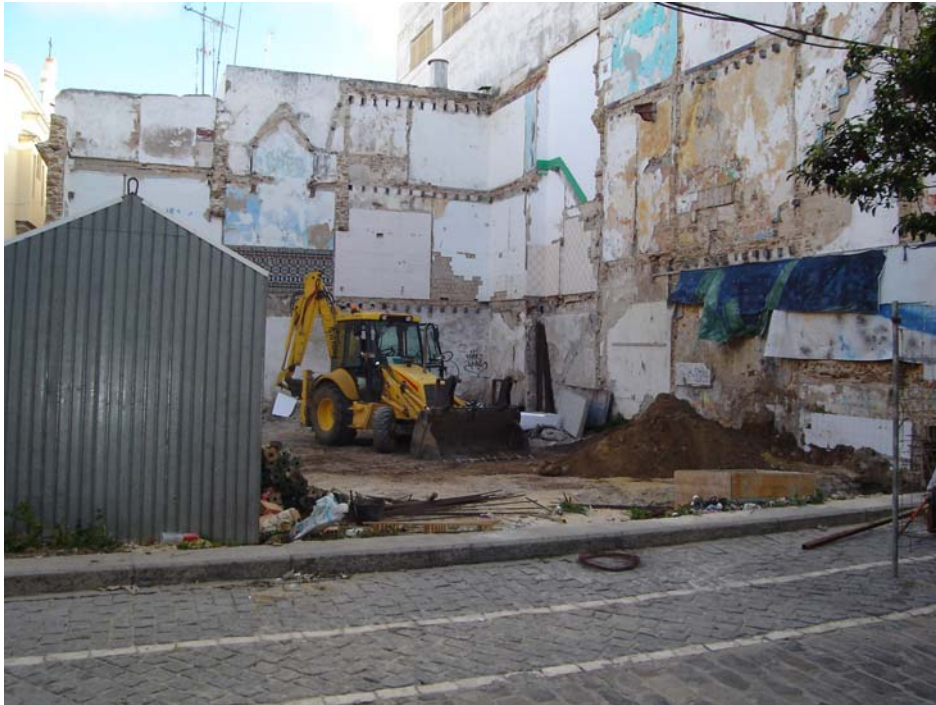
Lámina 1. Vista general desde la c/ de la Palma (Cádiz). Proceso de realización de los bataches.
