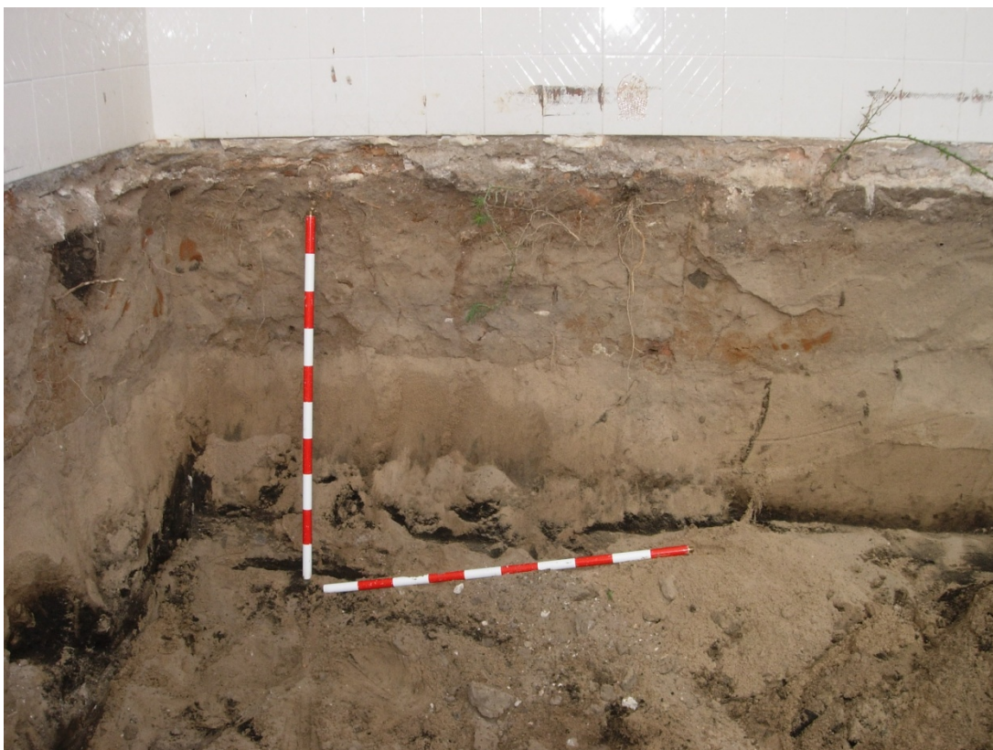
Lám. 1: Perfil W de los pozos de cimentación nº 11 y nº 12.
