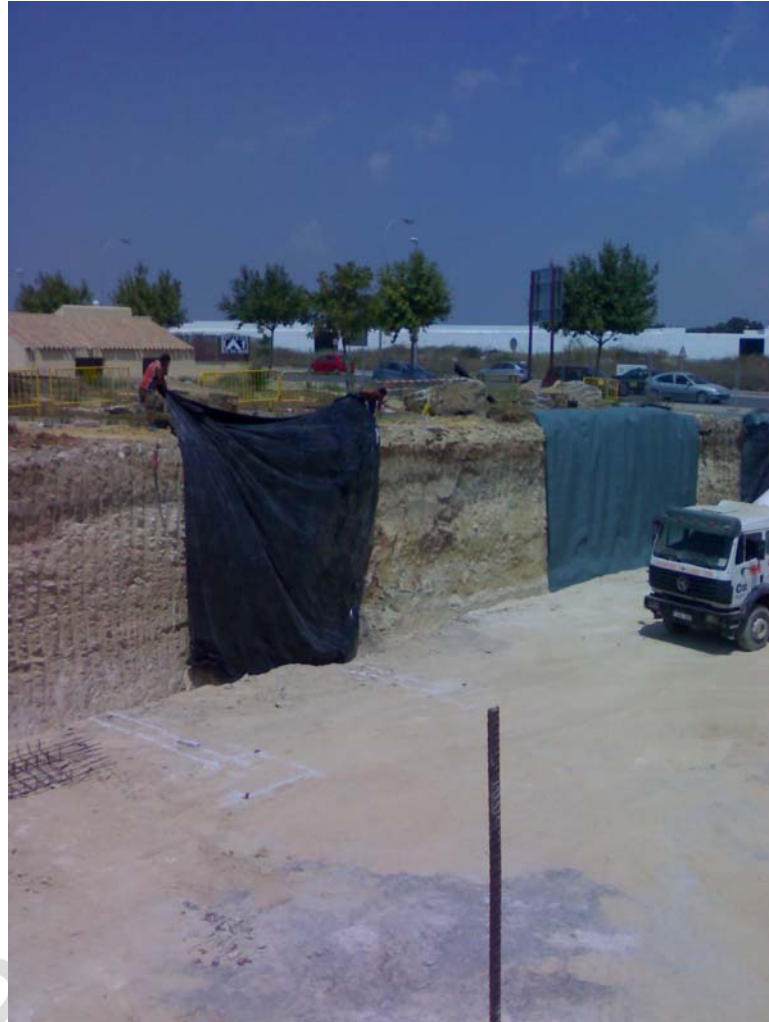
Lám. VIII: Colocación de la malla protectora de geotextil.
