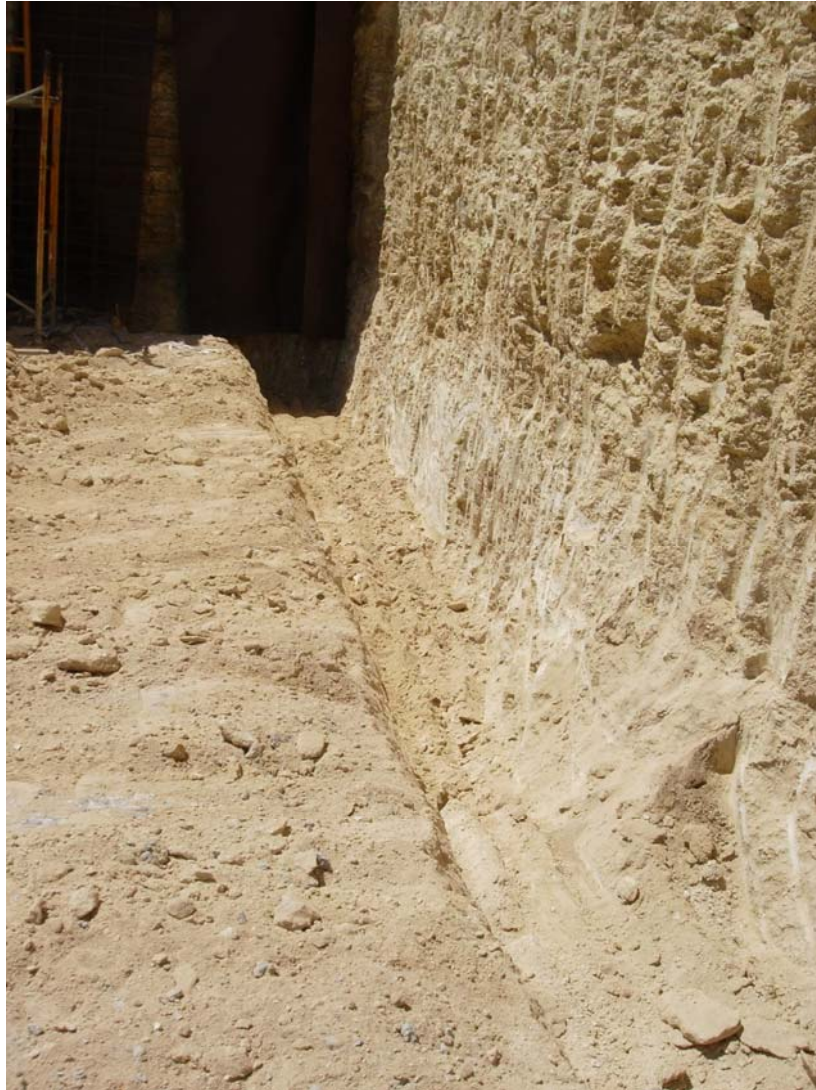
Lám. VI: Apertura de la cimentación.
