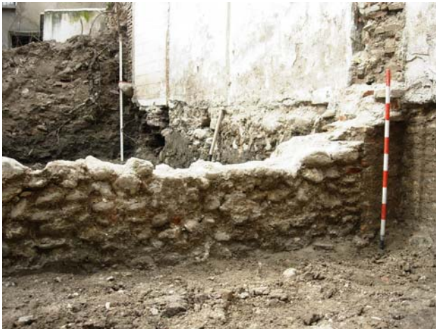
Alzado de la estructura. Se observa la fábrica de ladrillo en los extremos y la mampostería con tierra y cal en la parte central.
