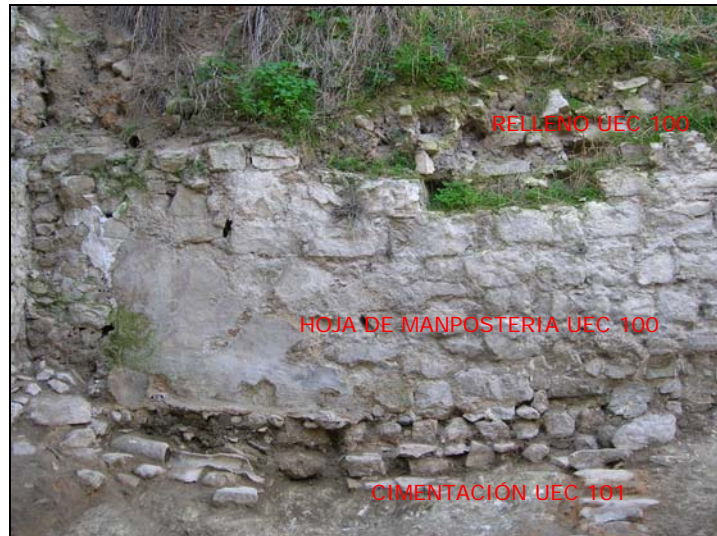
Lám. 7 Muro de aterrazamiento
