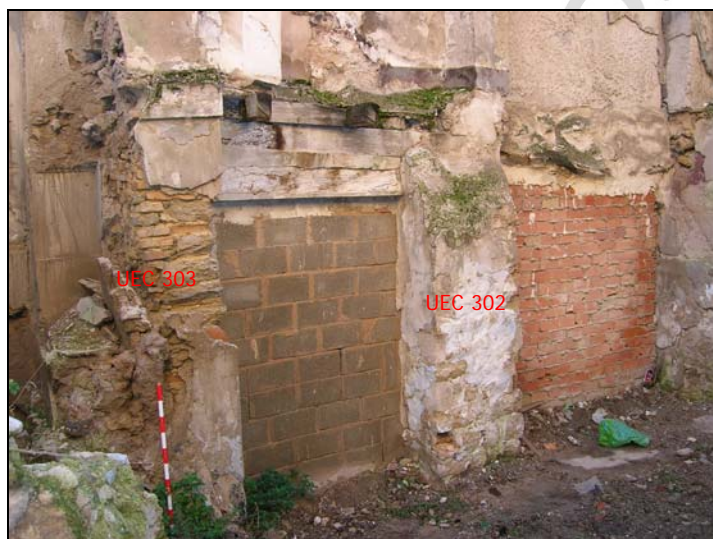
Lam 10. Vista general medianería Norte.
