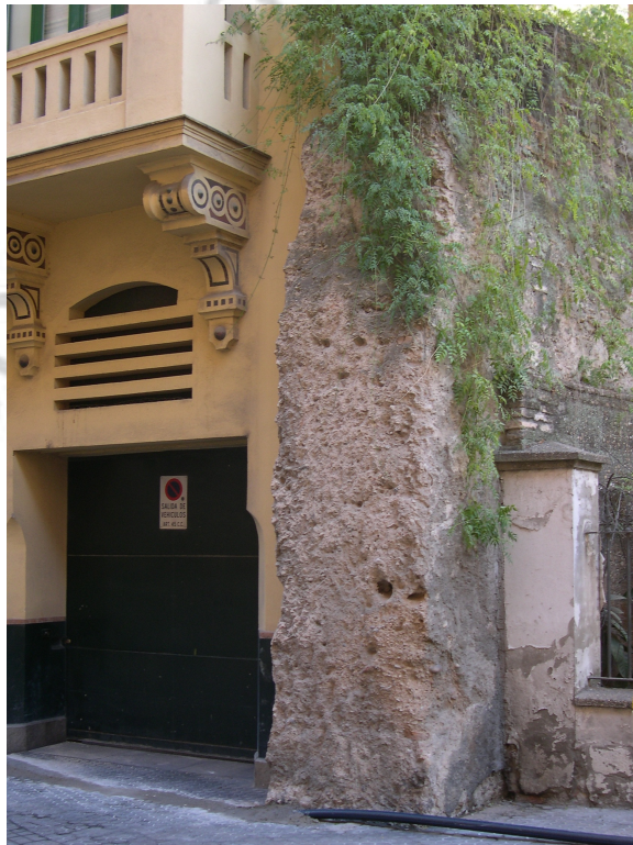
Lám.3. Tramo de muralla conservada en c/ San Gregorio
