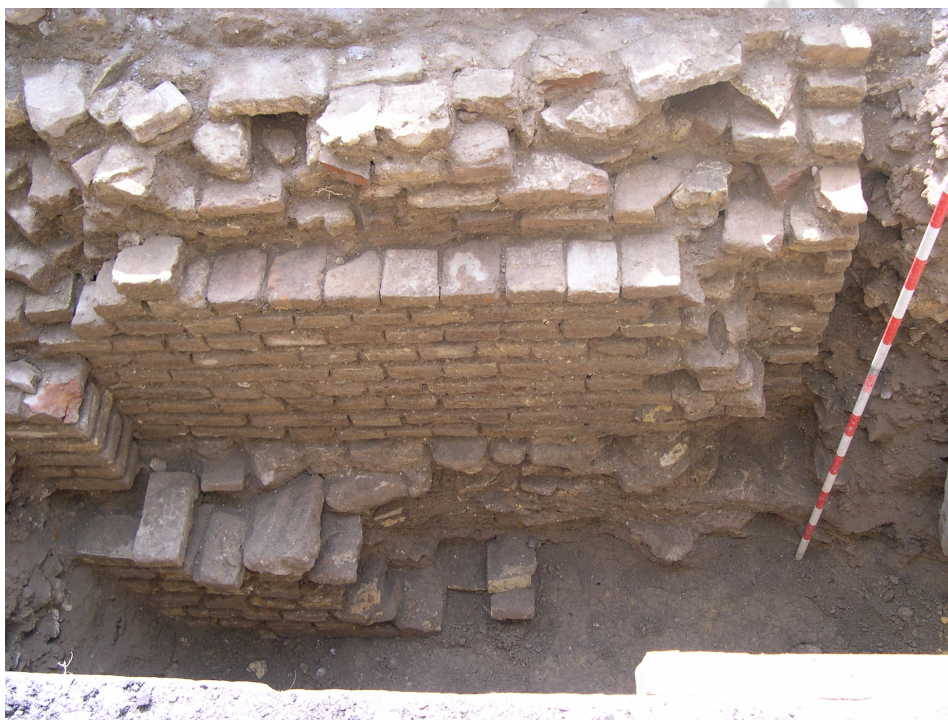
Lám. 1. Detalle de la esquina y contrafuerte del lienzo localizado en el Punto 9
